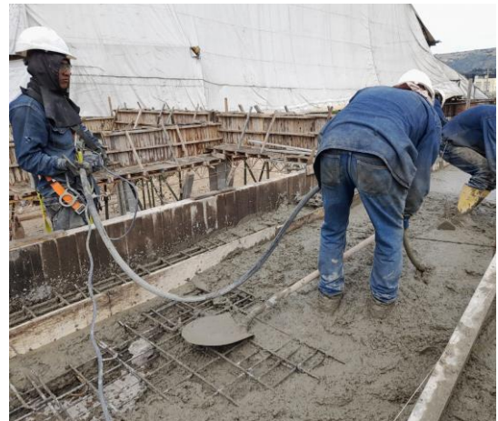
Ilustración 37. Vibrado de placa para canal del módulo 2.
