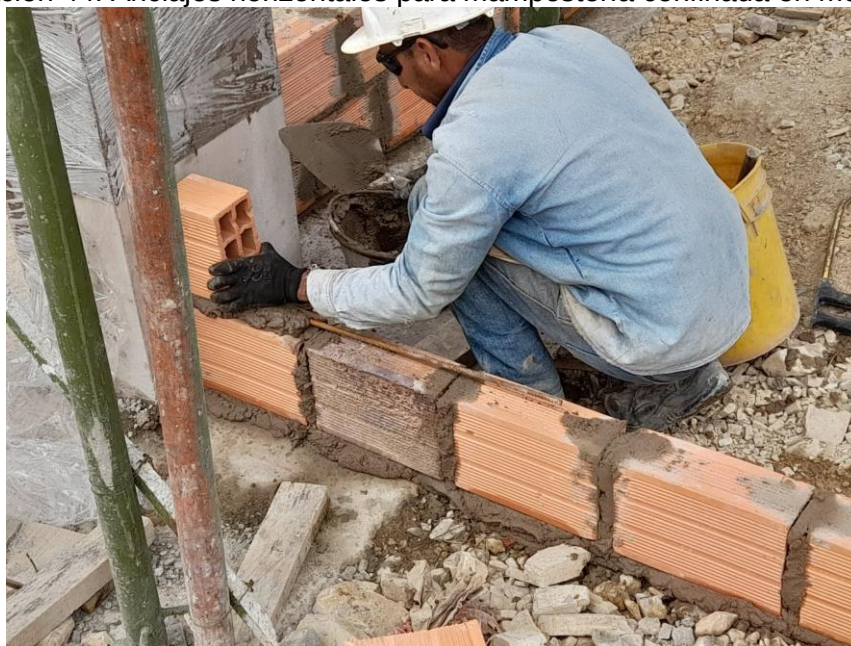
Ilustración 44. Anclajes horizontales para mampostería confinada en modulo 2.
