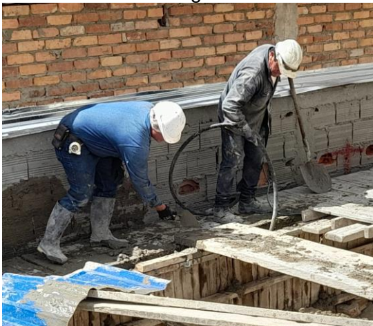
Ilustración 36. Vibrado de muros del canal de agua lluvia.
