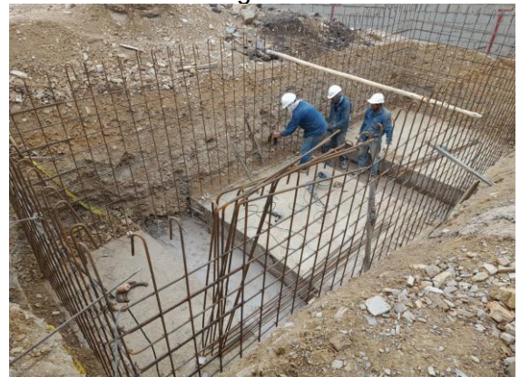
Ilustración 40. Acero de refuerzo de muros del tanque de almacenamiento de agua.
