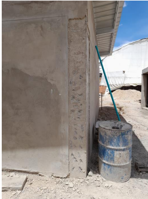
Ilustración 42. Escarificación de columnas en módulo 3.
