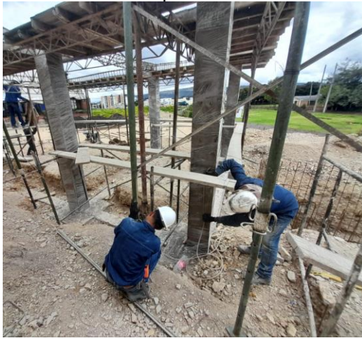
Ilustración 34. Paso de nivel manguera en parales.
