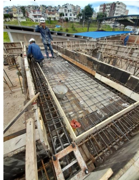
Ilustración 41. Acero de refuerzo de placa para canal del módulo 2.
