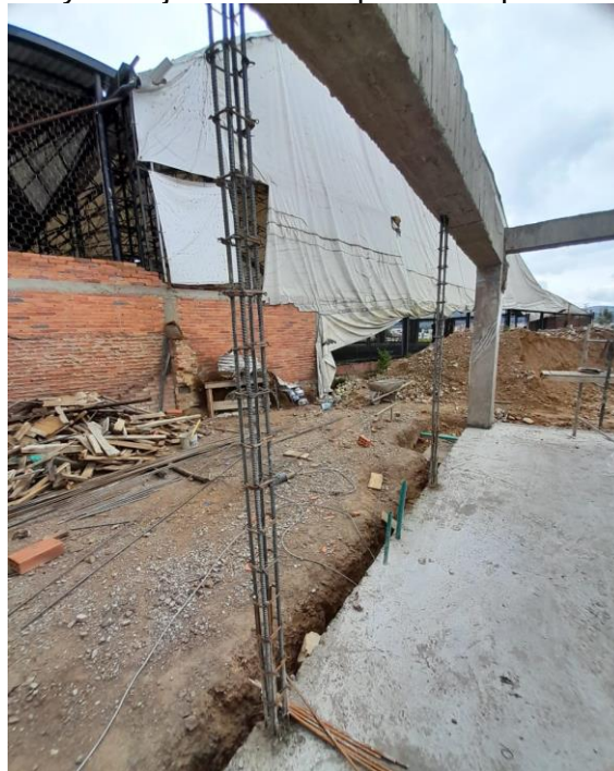
Ilustración 43. Columnetas y anclajes verticales para mampostería confinada en módulo 2.
