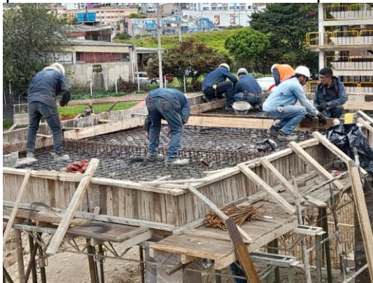
Ilustración 39. Acero de refuerzo para placa del cuarto de control de máquinas.
