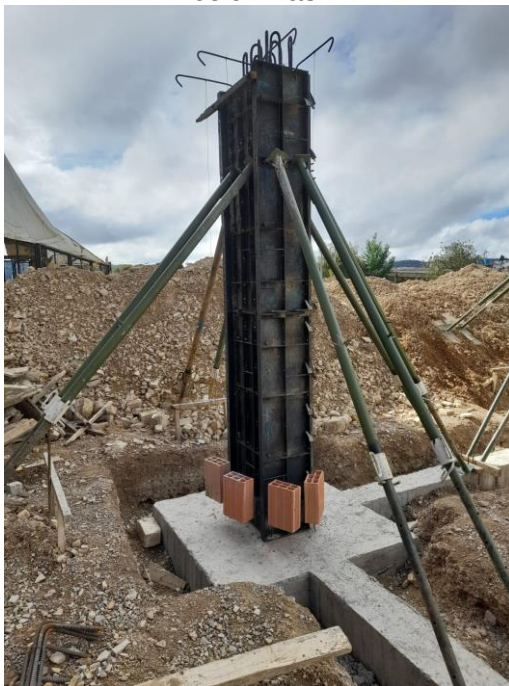
Ilustración 32. Plomada de formaleta de columnas.
