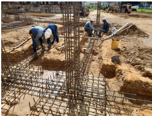
Ilustración 38. Acero de refuerzo de zapatas, vigas de cimentación y columnas del módulo 1.
