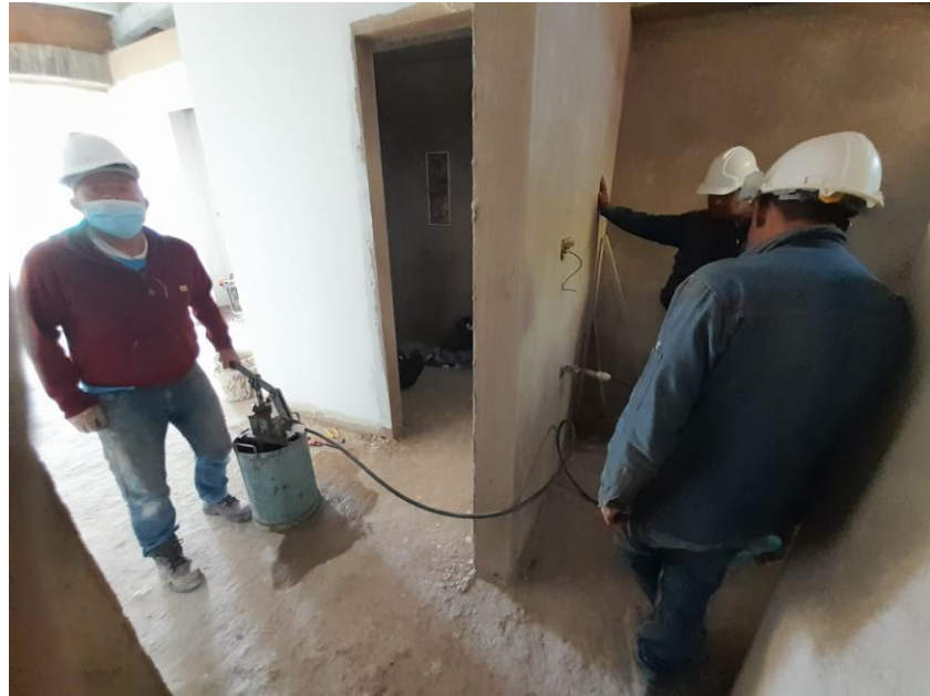
Ilustración 31. Prueba hidrostática en red hidráulica.
