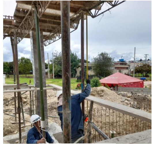
Ilustración 35. Nivelación vertical de formaleta para la placa.
