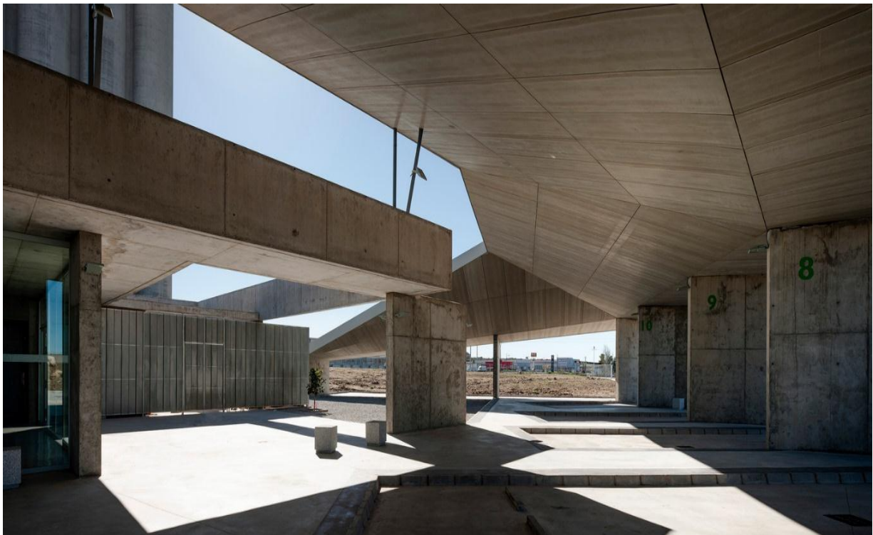
Figura 30. Interior del terminal de transporte de la ciudad de Trujillo, España. Tomada de ArchDaily.
