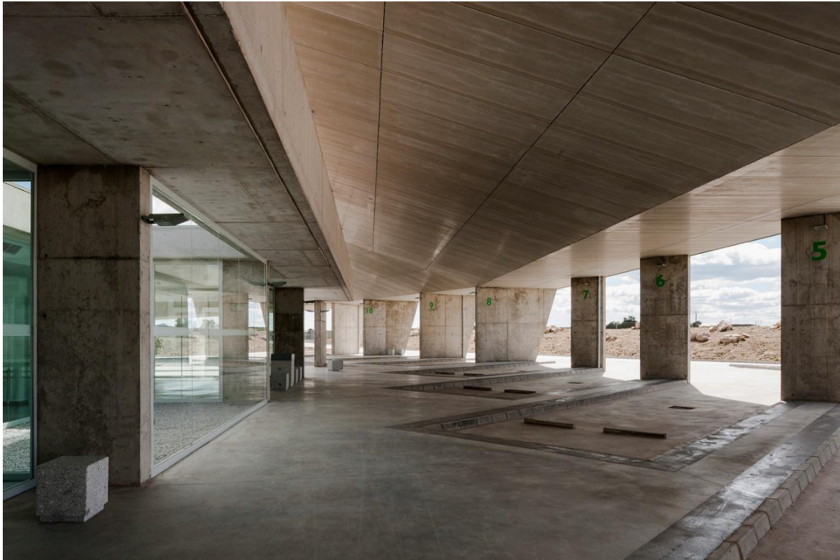
Figura 31. Zona de abordaje del terminal de transporte de la ciudad de Trujillo, España.
