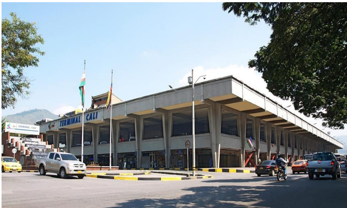
Figura 20. Terminal de transporte de la ciudad de Cali. Tomada de Terminal Cali
