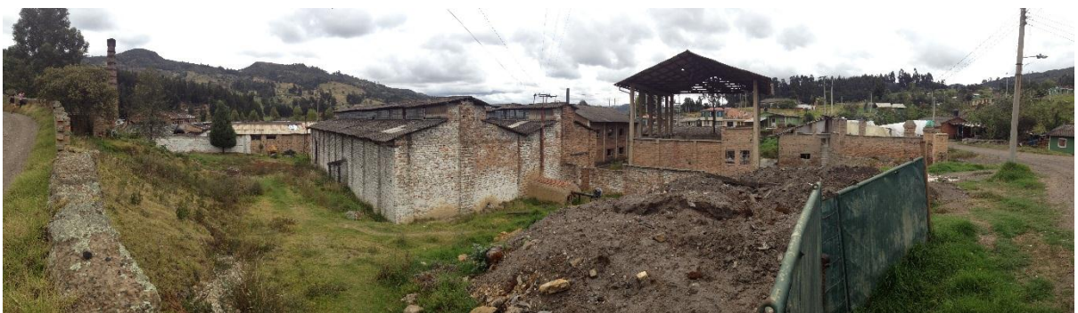
FACHADA POSTERIOR VISTA 3
