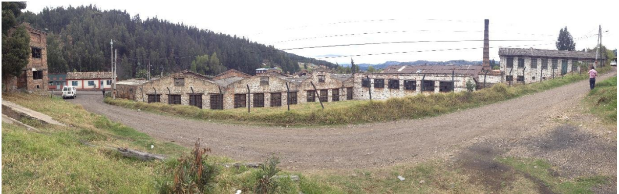
FACHADA POSTERIOR VISTA 1
