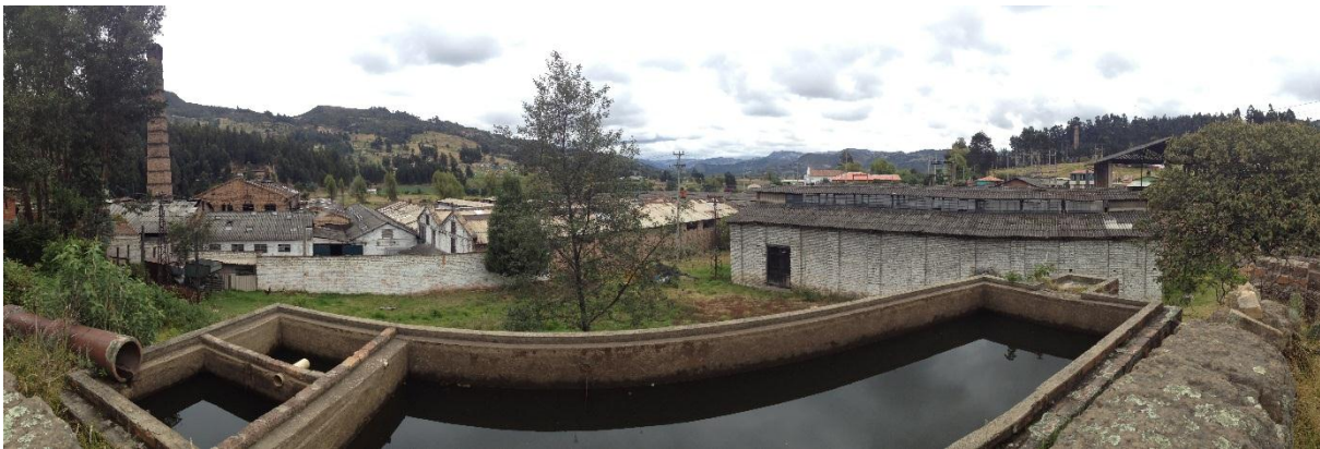
FACHADA POSTERIOR VISTA 2
