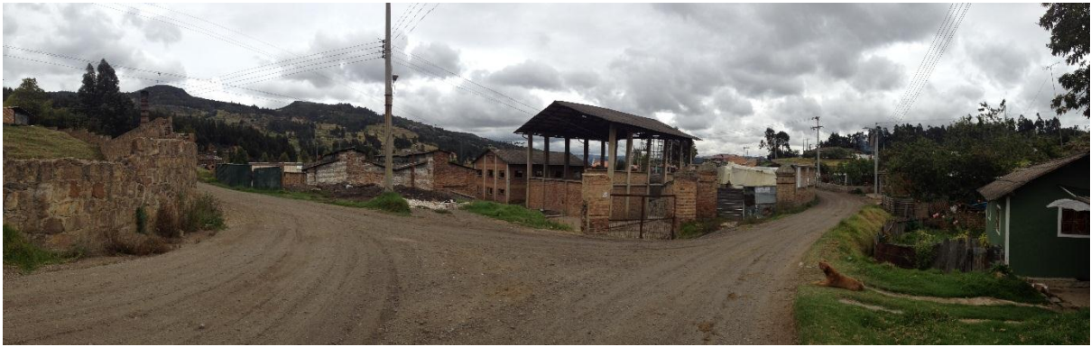
FACHADA POSTERIOR VISTA 4
