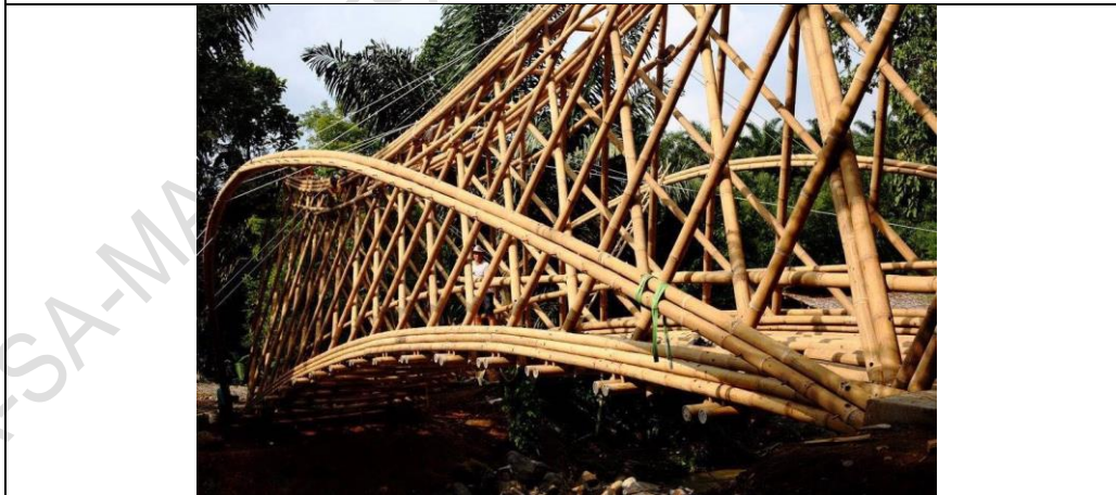
Fotografía 21: Puente peatonal en Sumatra Indonesia, longitud de 37 metros. Construido en 2017. Fuente: Puente de carretera de Bambu, 2017. Fibra Awar
