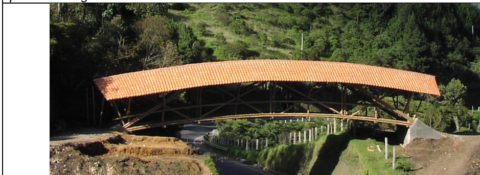
Fotografía 9: Puente en bambú ubicado en la Ciudad de Pasto en el departamento de Nariño, Construido en 2005. Fuente: Stamm J., 2005. Curso de construcción de puentes en guadua.
