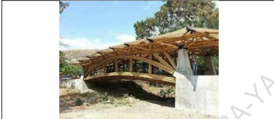
Fotografía 15: Puente ubicado en el corregimiento de Mulaló, municipio del Valle del Cauca. Construido en el año 2005. Fuente: Stamm J., 2005. Curso de construcción de puentes en guadua.
