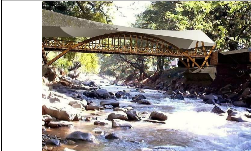
Fotografía 12: Puente Fundeguada, se construyó sobre el río Cali, en el año 2004. Fuente: Stamm J., 2005. Curso de construcción de puentes en guadua.
