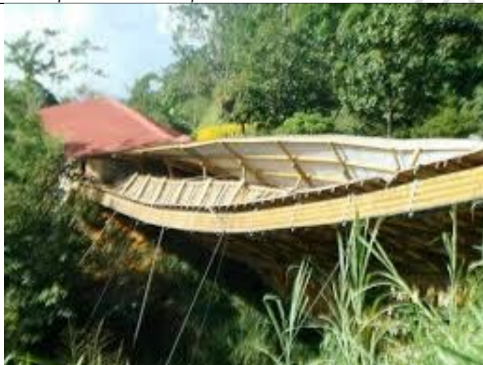
Fotografía 14: Puente ubicado en Santo Domingo Medellín, fue construido en el 2008. Fuente: Sánchez D., 2013. Medellín: el puente de guadua que también colapsó.
