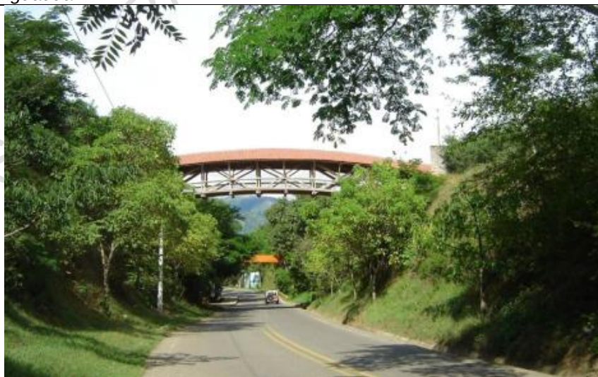
Fotografía 13: Puente ubicado en Santa Fe de Antioquia, construido en Septiembre 2005. Fuente: Stamm J., 2005. Curso de construcción de puentes en guadua.
