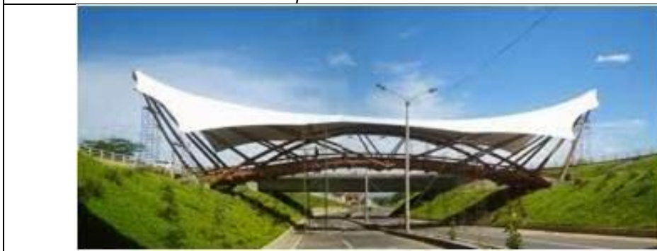
Fotografía 10: Puente peatonal construido en la ciudad de Cúcuta, Colombia. En julio 2008. Fuente Jacome J. 2014. El puente de Guadua Arnulfo Briceño.
