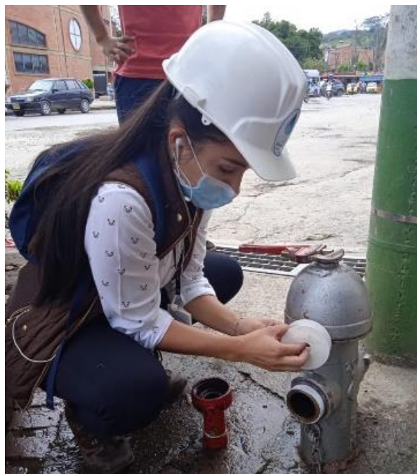
Figura 26. Inspección y mantenimiento de hidrantes
