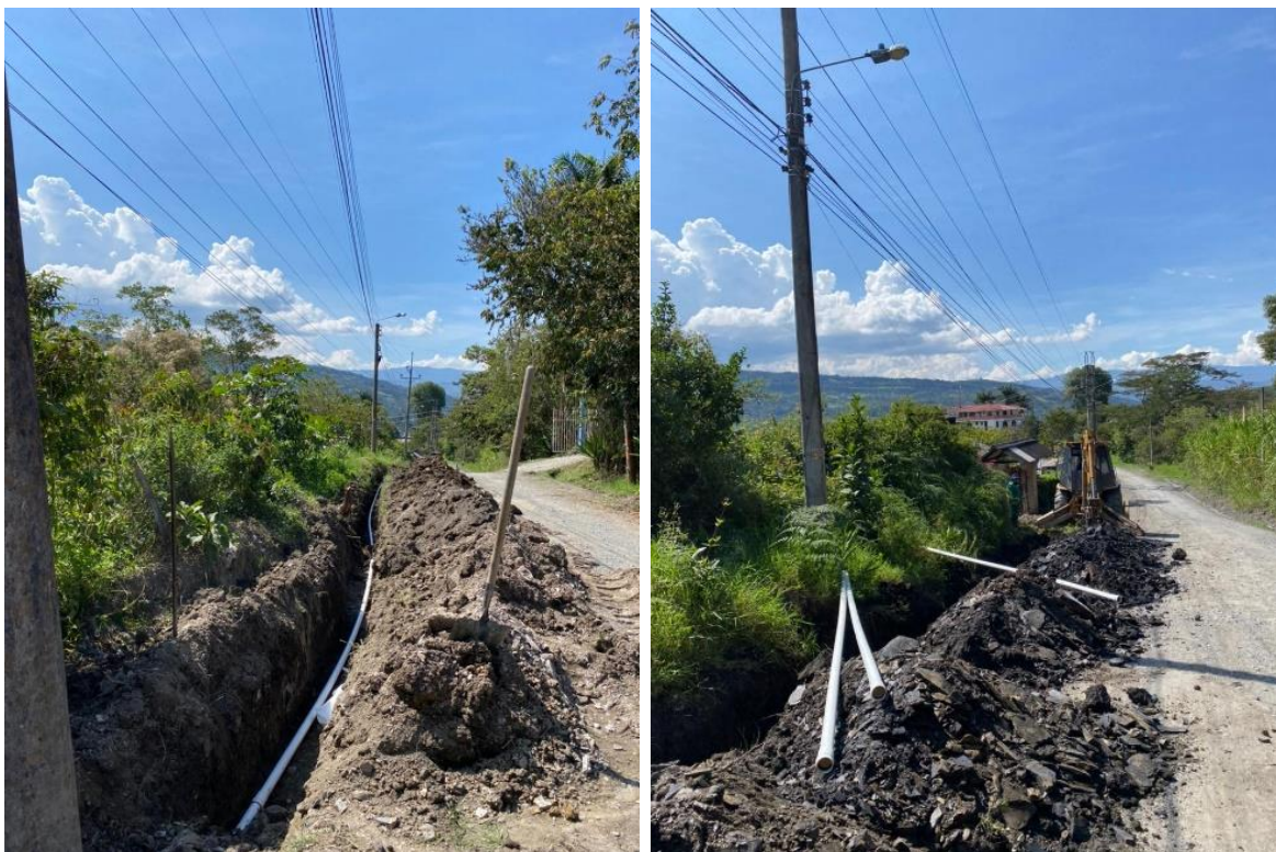
Figura 8. Instalación de tubería de agua potable tramo 1 (izquierda). Instalación de tubería de agua potable tramo 2 (derecha).
