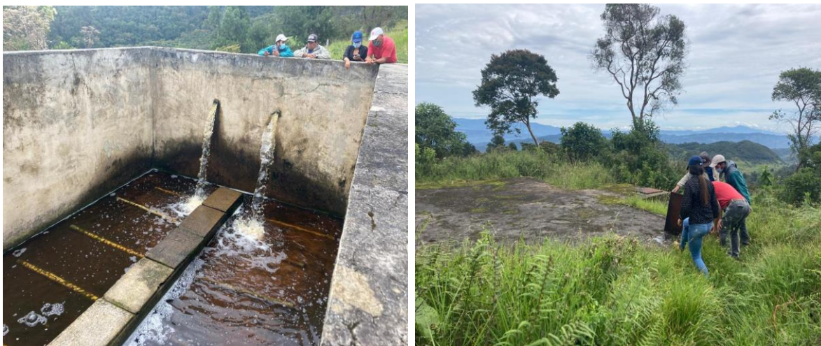
Figura 16. Acueducto veredal sector “Tierra de Castro” (izquierdo). Acueducto veredal sector “Tierra de Castro” tanque de almacenamiento (derecho).
