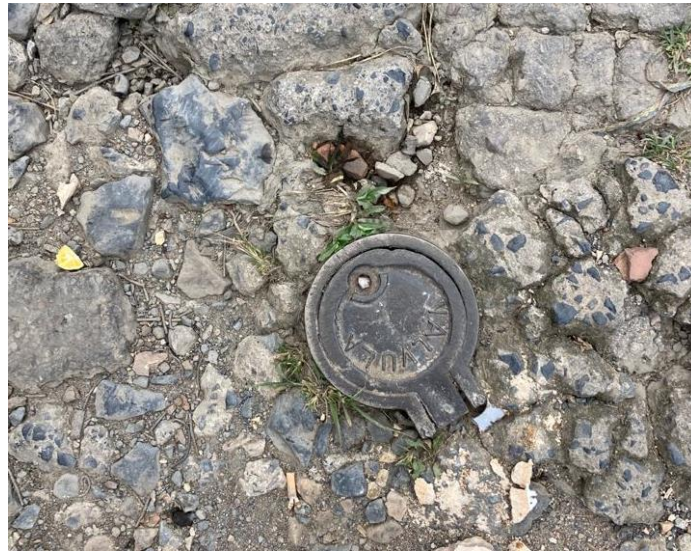
Figura 20. Toma de coordenadas válvulas de corte.
