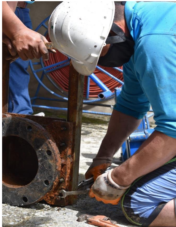
Figura 25. Válvula de corte filtro 2.
