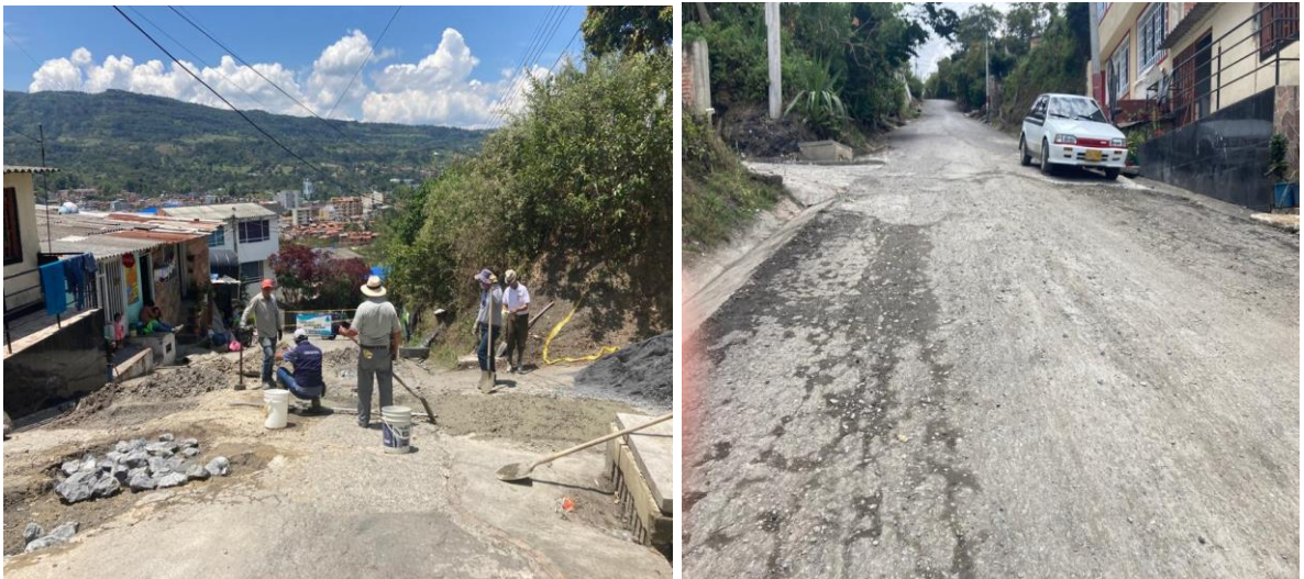
Figura 9. Día 1 mantenimiento correctivo Cra1 (izquierda). Día 2 mantenimiento correctivo Cra1 (derecha)
