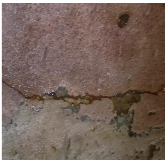
Figura 14. Tanque No. 2 Falla estructural (izquierda). Tanque No. 2 Fatiga estructural vértices o juntas (derecha).
