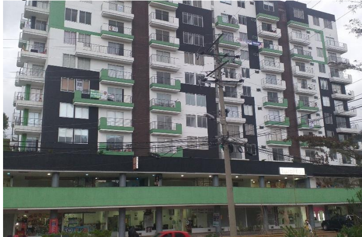
Figura 19. Toma de coordenadas vertimiento No. 88.
