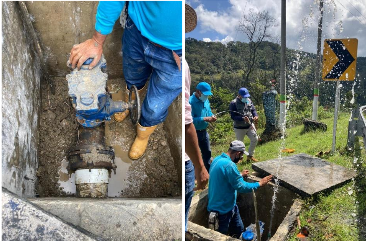
Figura 7. Instalación de collarín red de acueducto veredal del norte. (izquierda). Instalación de collarín red de acueducto veredal del norte (derecha).
