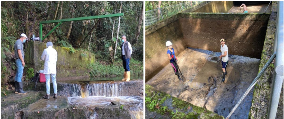
Figura 12. Bocatoma de aducción quebrada la Sicha, vereda San Cristóbal. (izquierda). Tanque desarenador ESPM, vereda San Cristóbal (derecha).
