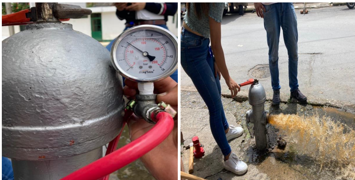
Figura 24. Toma de presiones con Barometro (izquierda). Lavado de Hidrantes (derecha).
