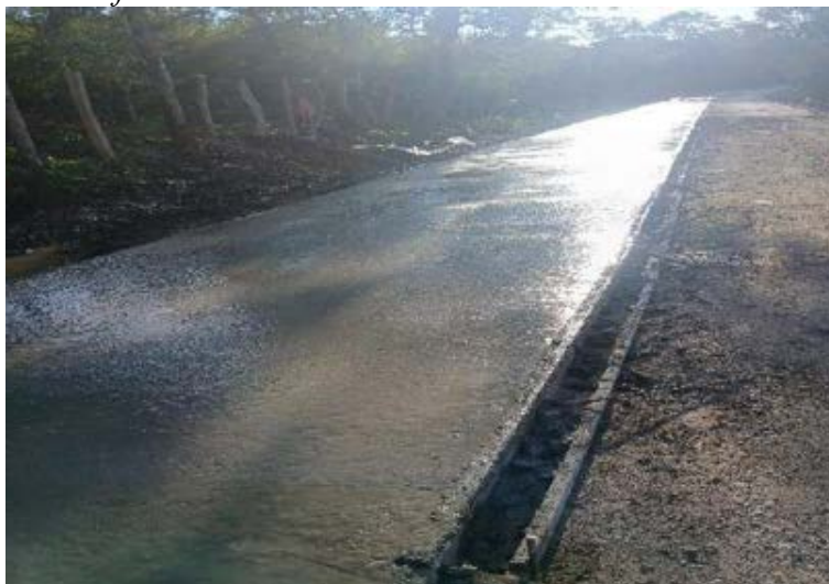
Figura 291. Tramo recién fundido.
