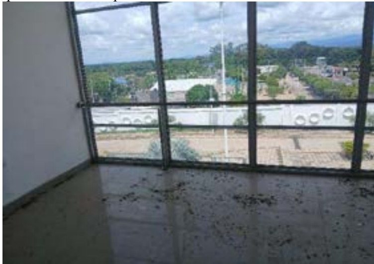
Figura 162. Tercer piso sala de cómputo.
