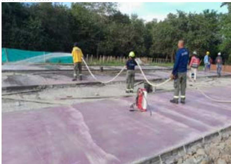
Figura 298. Remojado de losas.
