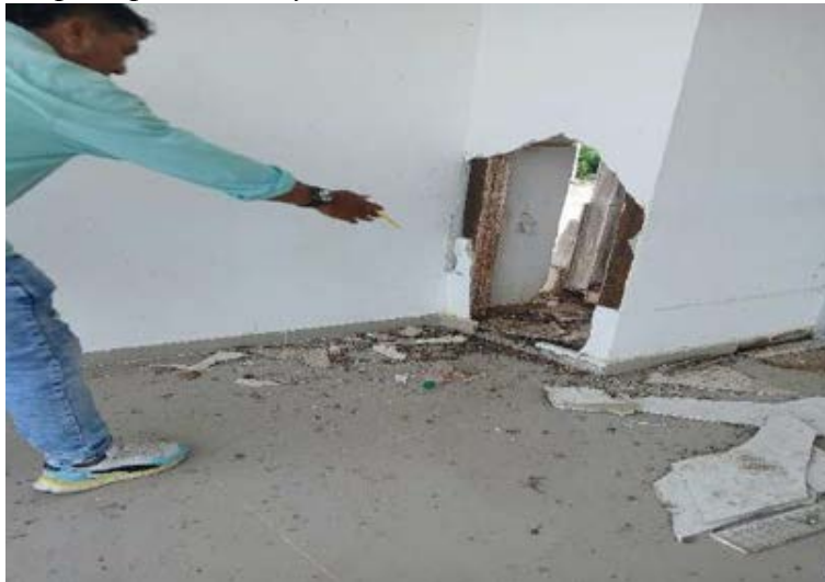
Figura 164. Medición para pared de drywall.
