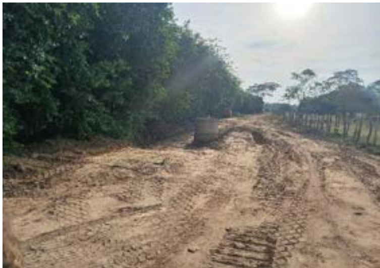
Figura 215. Manjol a desnivel del trazado vial.
