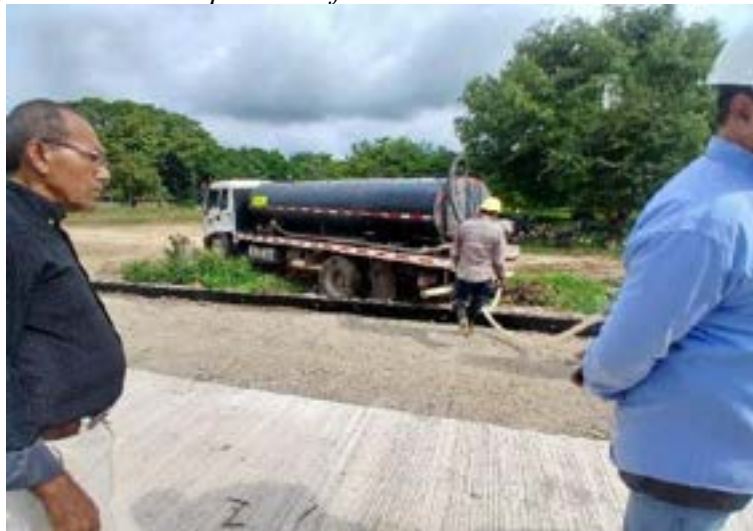
Figura 115. Remojado del terreno previo al fundido.
