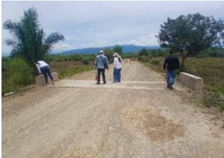
Figura 29. Verificación del estado de box culvert.
