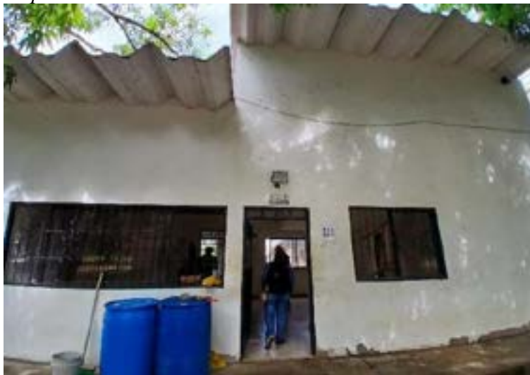
Figura 135. Fachada parte administrativa.
