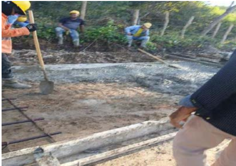
Figura 290. Operarios en labor.
