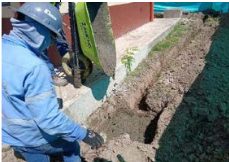
Figura 245. Fundido de concreto para cimentación.
