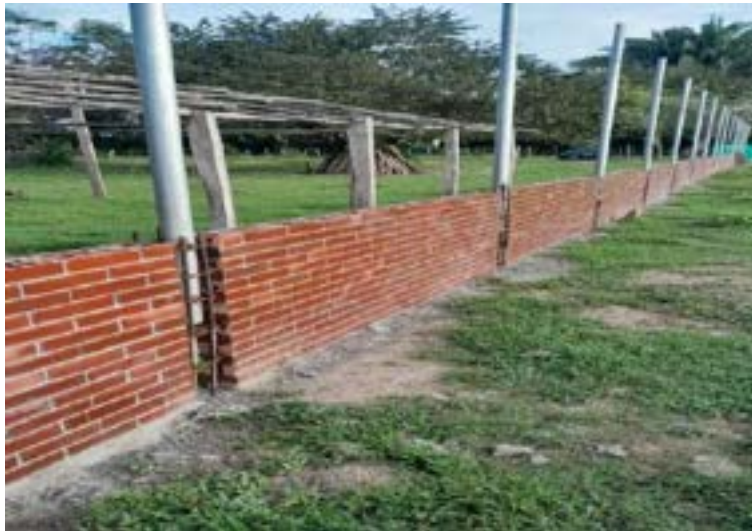
Figura 292. Mampostería del cerramiento.
