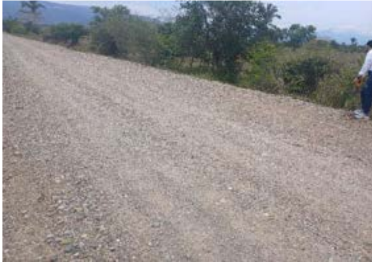
Figura 23. verificación del estado de box culvert.
