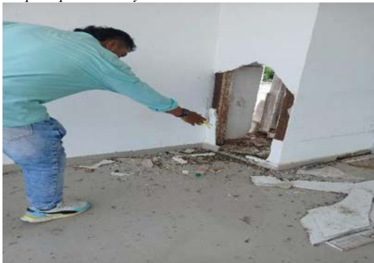
Figura 165. Medición para pared de drywall.
