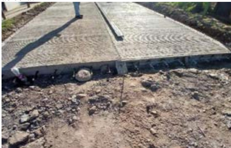
Figura 225. Inicio de obra.
