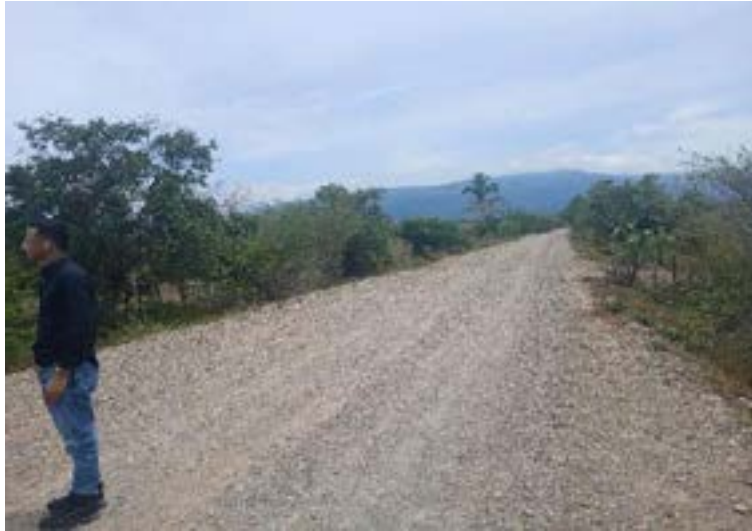
Figura 24. Verificación del estado de la subbase.
