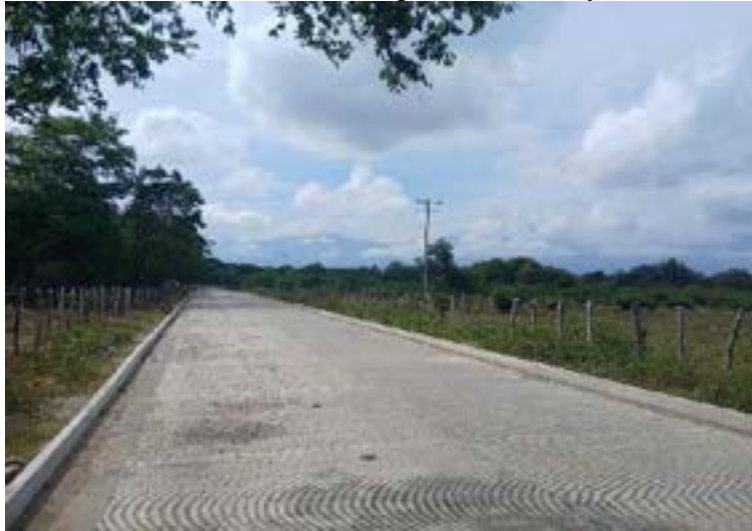
Figura 5. Vía que conecta el corredor vial con la planta de sacrificio.
