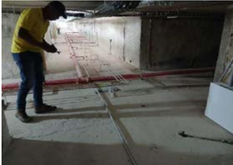
Figura 95. Recorrido hacia la azotea.
