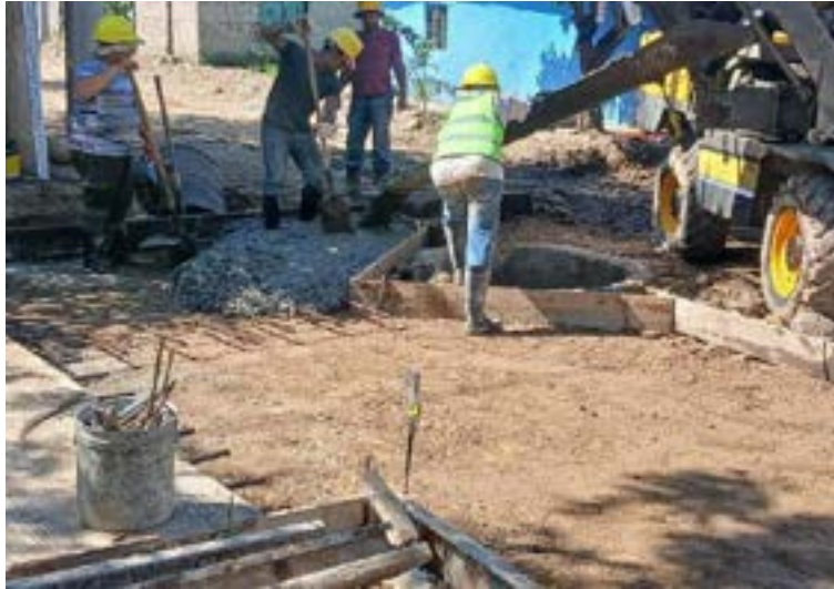
Figura 236. Fundido de la losa.
