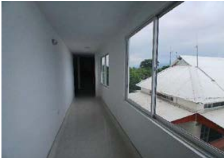
Figura 67. Pasillo lado derecho.
