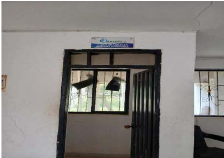
Figura 152. Oficina de cableado eléctrico.
