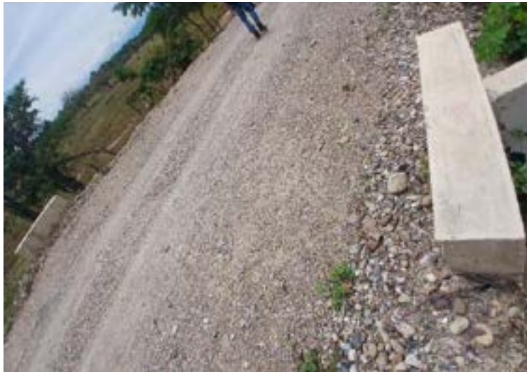
Figura 25. Verificación del estado de box culvert.
