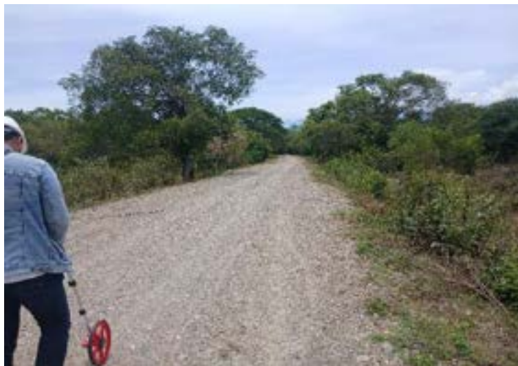
Figura 31. Verificación del estado de subbase.
