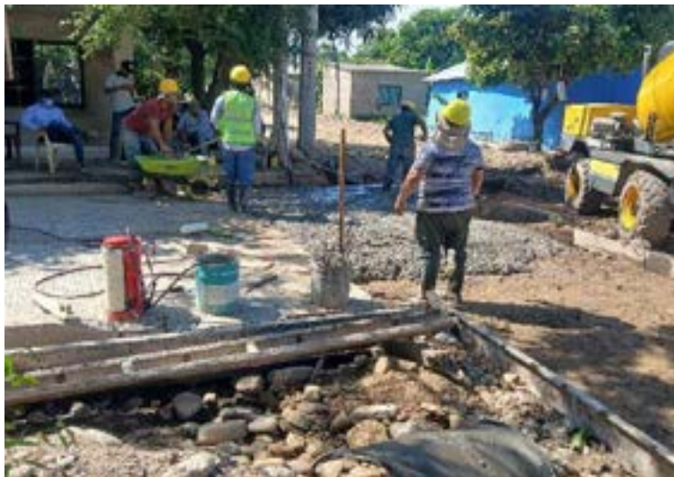
Figura 237. Vibrado del concreto.
