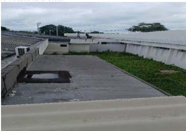
Figura 106. Medición desde la azotea.
