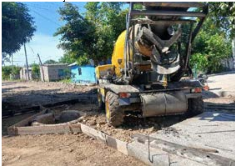
Figura 235. Preparando de la maquinaria.
