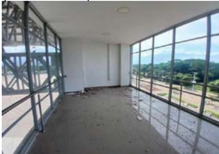
Figura 166. Tercer piso de la sala de cómputo.
