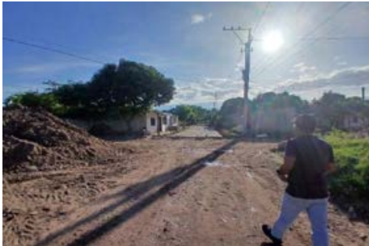
Figura 224. Llegada a la obra.
