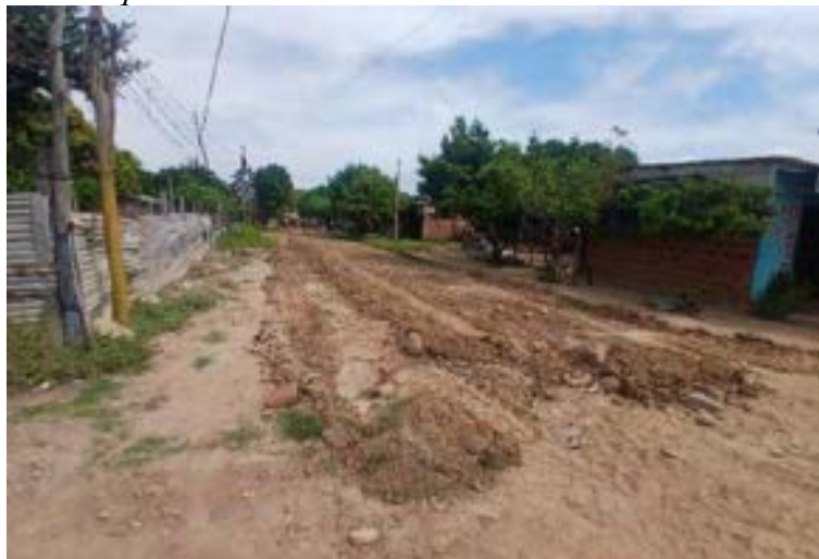
Figura 188. Pasado de maquinaria en tramo.
