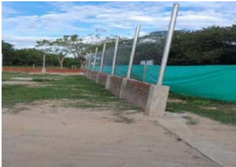
Figura 293. Tramo de cerramiento terminado.
