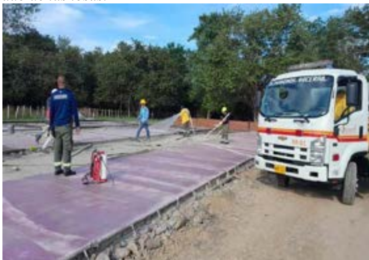
Figura 297. Remojado de las losas.
