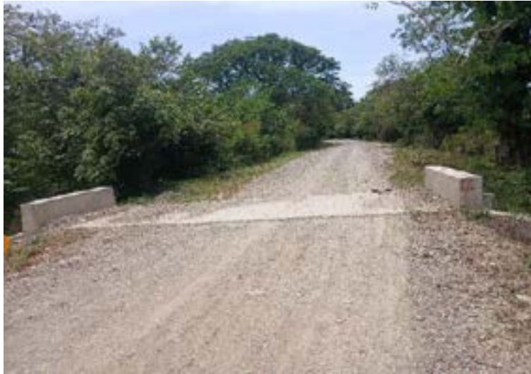
Figura 32. Verificación del estado de box culvert.
