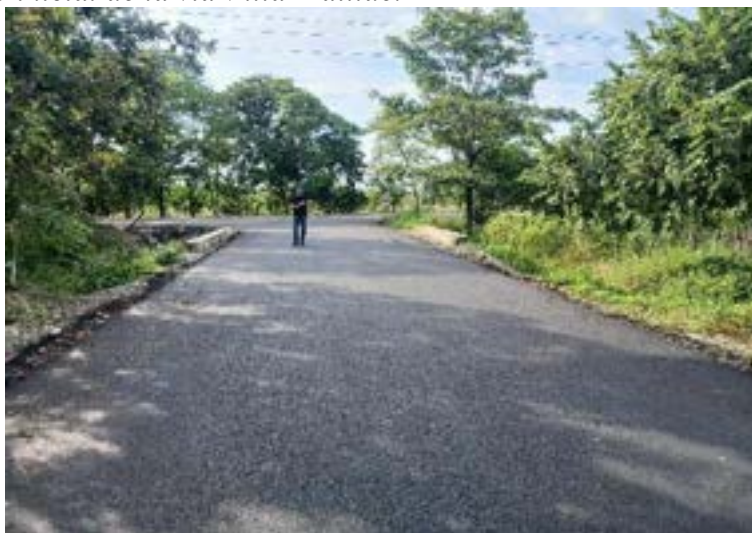
Figura 197. Tramo inicial de la vía Villa Matilde.
