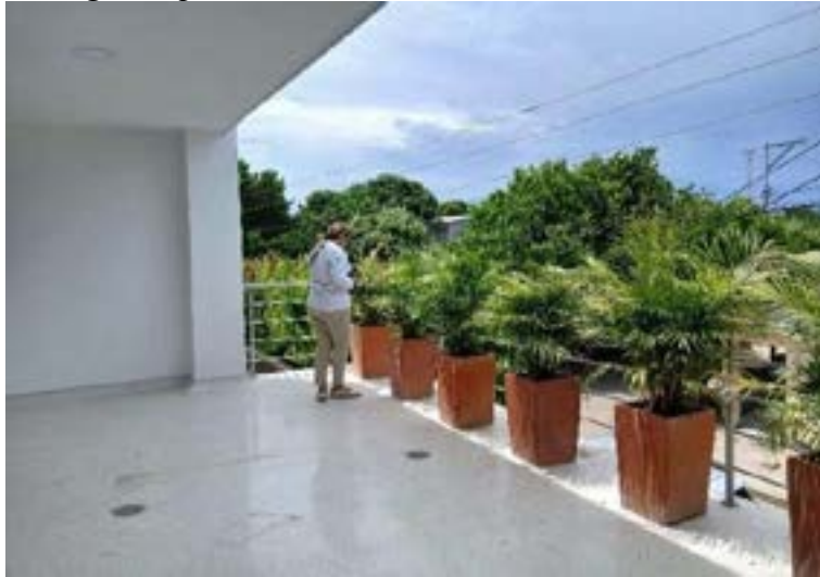
Figura 60. Balcón del segundo piso.
