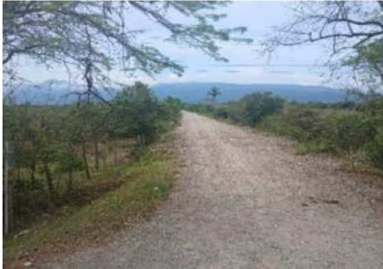
Figura 22. Comienzo de la obra.
