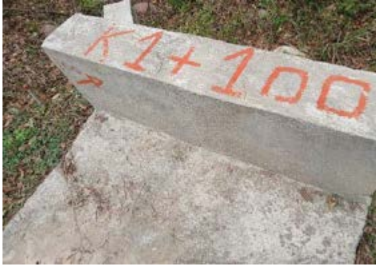
Figura 36. Verificación del estado de box culvert, otra perspectiva de la inspección de un box culvert, enfocándose en los Km, posibles obstrucciones y/o daños estructurales.
