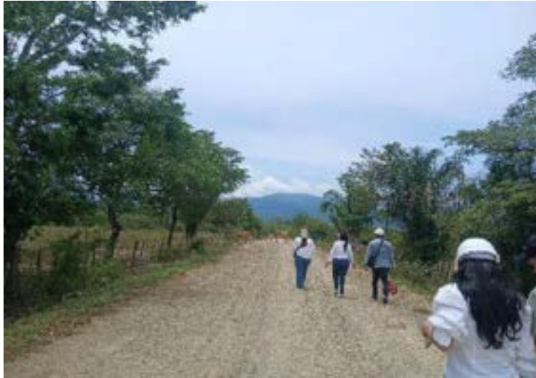
Figura 28. Verificación del estado de subbase.
