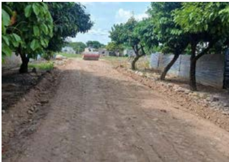
Figura 194. Maquinaria de aplanado.
