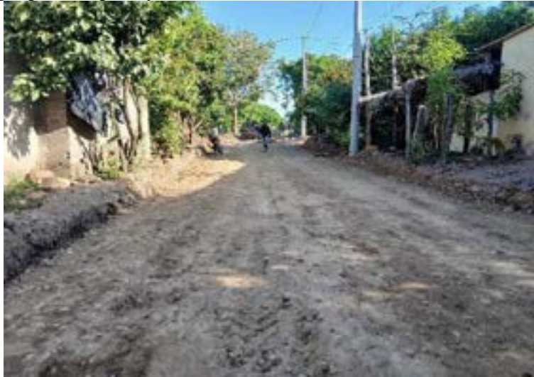
Figura 228. Calle preparada para fundir las losas.
