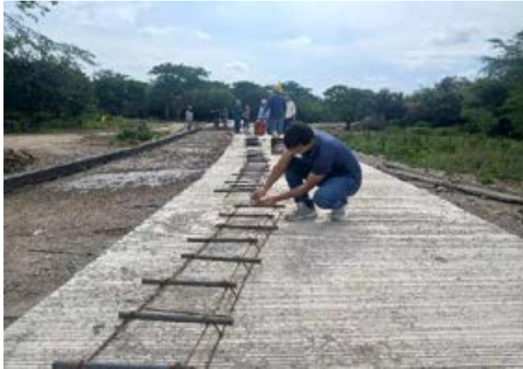
Figura 118. Verificación de dovelas.
