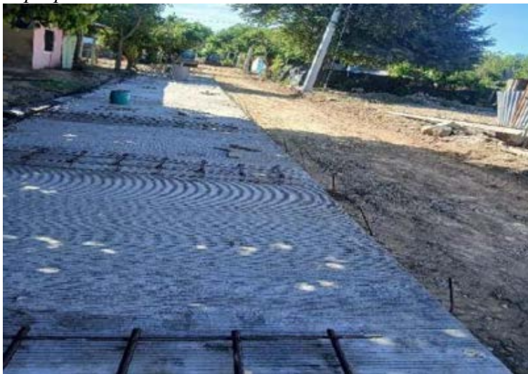
Figura 250. Dovelas preparadas.
