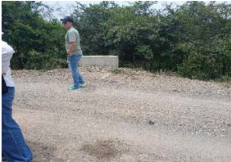
Figura 27. Verificación del estado del box culvert.
