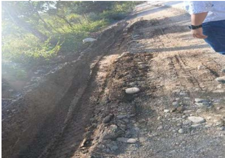
Figura 284. Hundimiento por volquetas.
