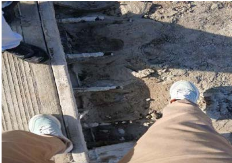
Figura 226. Dovelas cubiertas de mortero.
