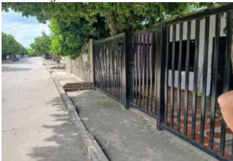
Figura 123. Inspección en el lugar.
