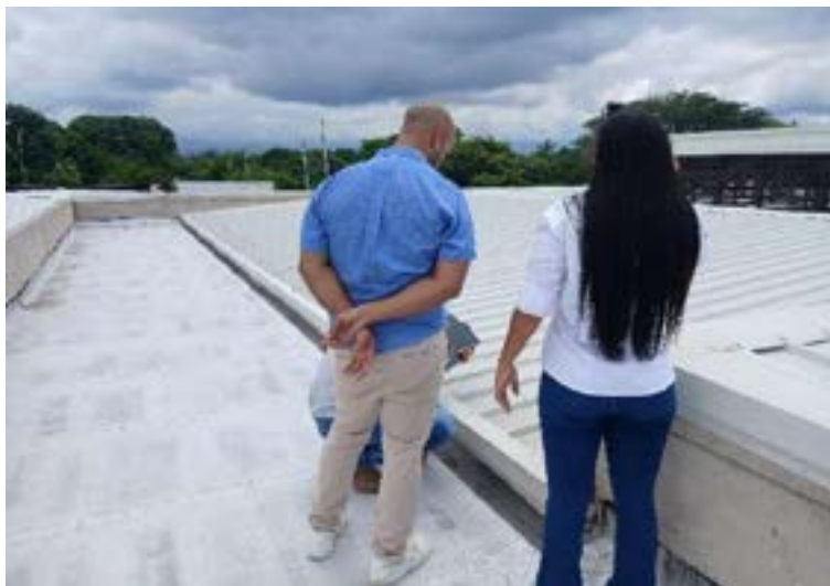
Figura 98. Tuberías de la azotea.
