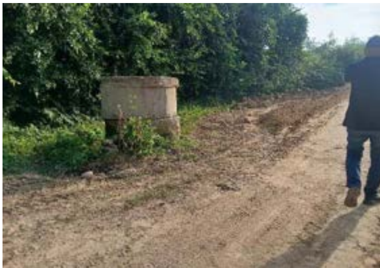
Figura 211. Manjol de desnivel del trazado vial.
