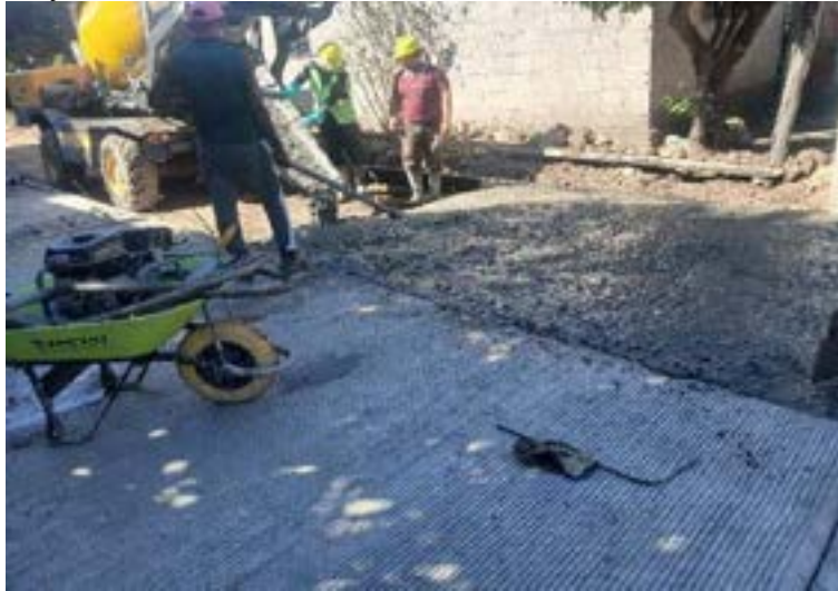
Figura 251. Concreto fundido.
