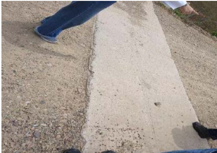
Figura 30. verificación de medida de box culvert.
