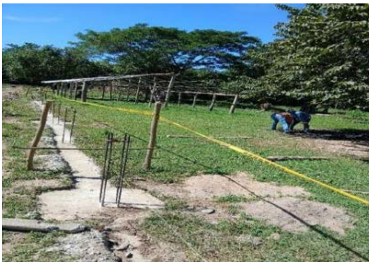
Figura 239. Cimentación del muro de cerramiento.
