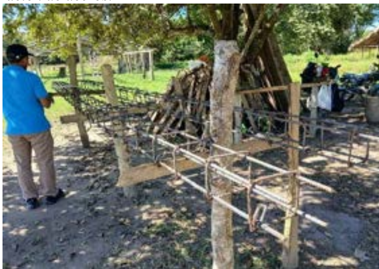
Figura 241. Preparación de aceros.
