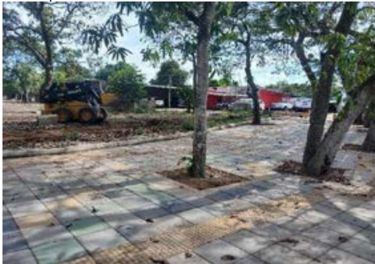
Figura 43. Inspección de adoquines.
