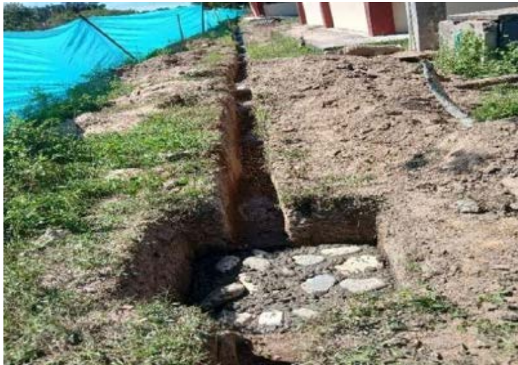
Figura 243. Fundido de la cimentación.
