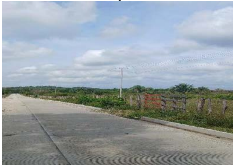
Figura 6. Vía que conecta el corredor vía con la planta.
