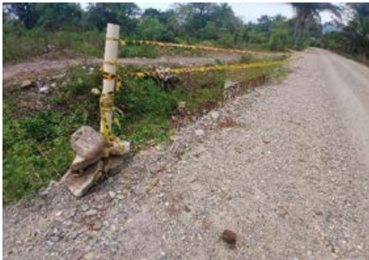
Figura 38. Verificación del estado de subbase.
