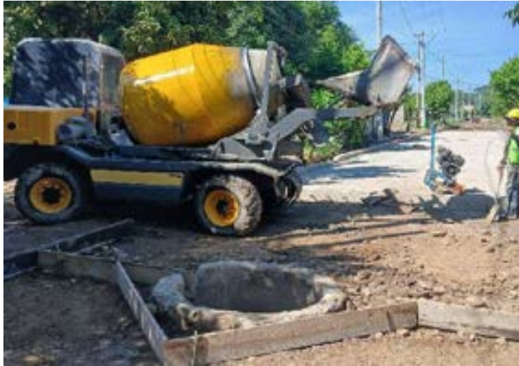
Figura 234. Llegada del mixer de 2.5 metros cúbicos.
