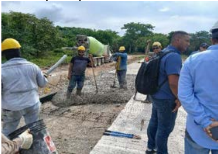
Figura 117. Operarios distribuyendo el fundido.
