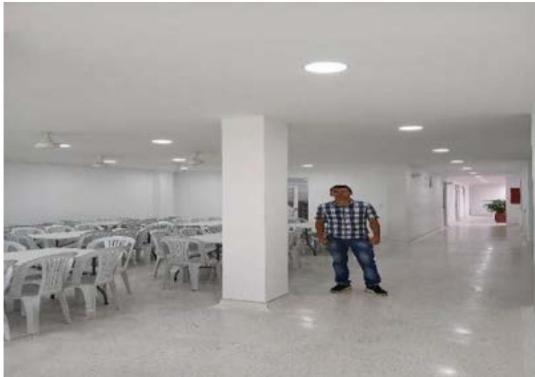
Figura 50. Prueba de luminarias.
