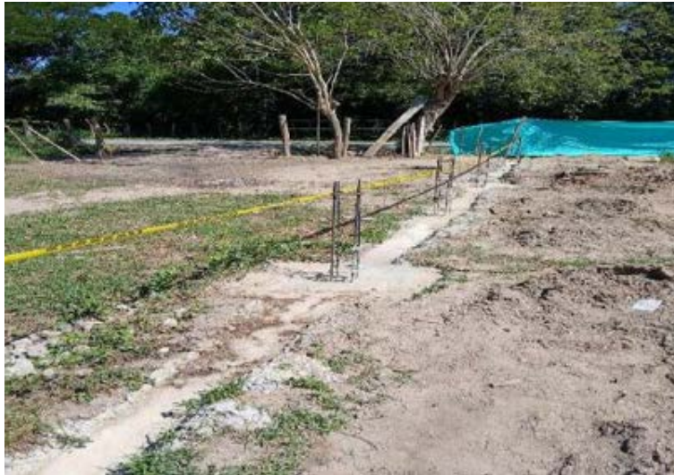
Figura 238. Cimentación del muro de cerramiento.
