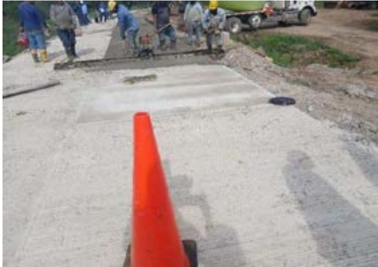
Figura 120. Obreros vibrando el concreto.
