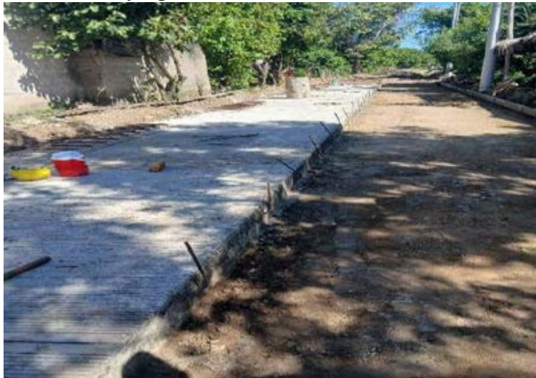
Figura 230. Concreto de la losa fraguado.
