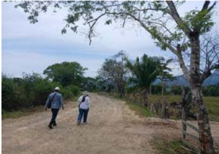
Figura 37. Verificación del estado de subbase.
