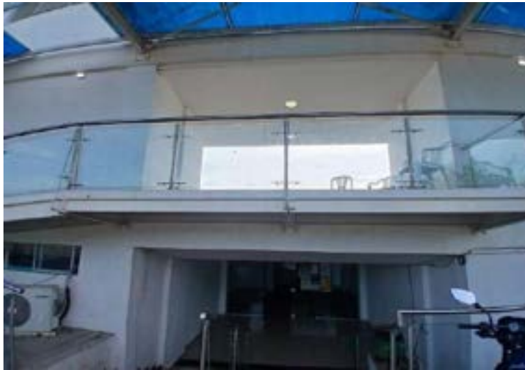
Figura 154. Entrada a la sede.
