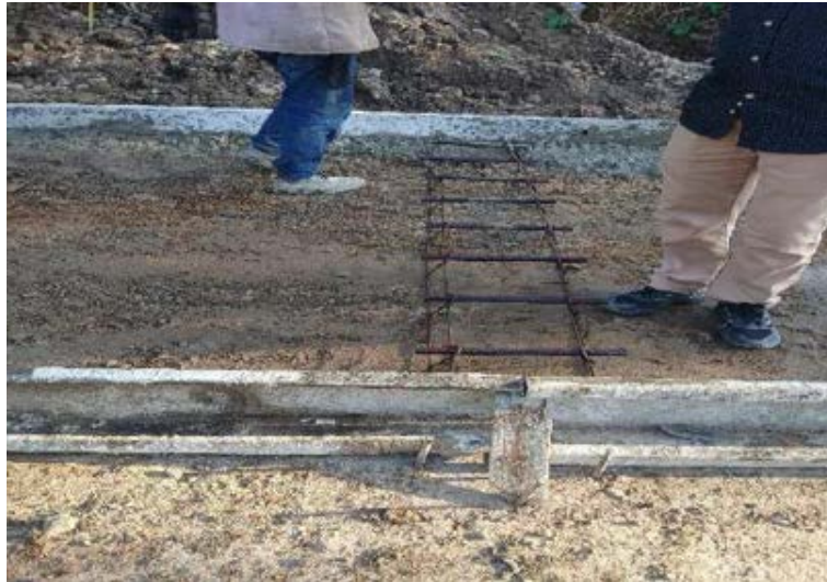
Figura 289. Revisión de dovelas.
