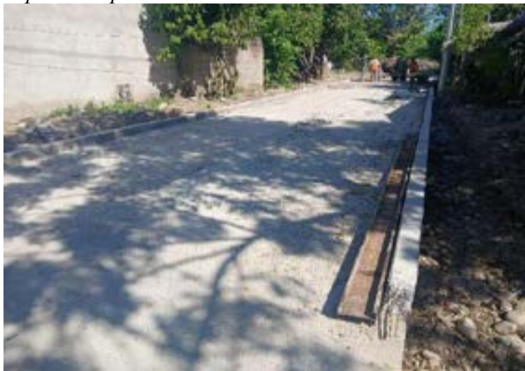
Figura 248. Bordillo para completar.
