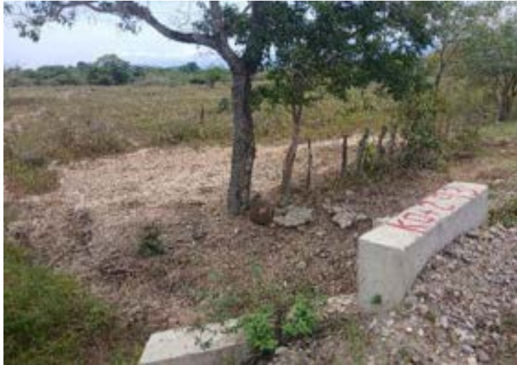
Figura 26. Verificación del estado de box culvert.
