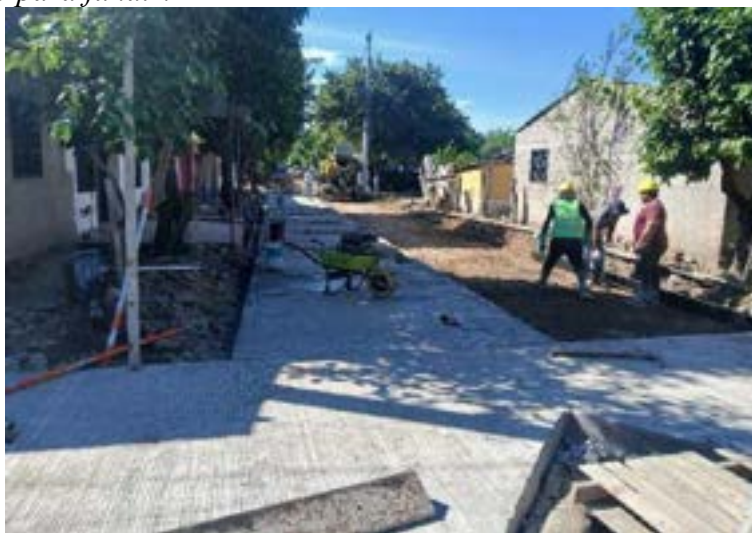
Figura 249. Tramo para fundir.
