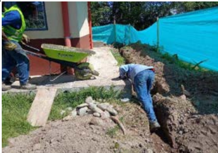
Figura 244. Transportado de concreto.
