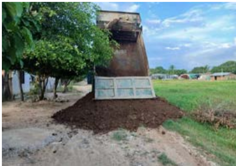
Figura 187. Descargue de arena en el tramo cerca de la cancha.
