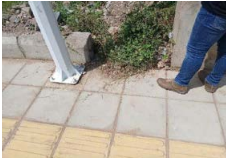
Figura 45. Inspección de bordillos.
