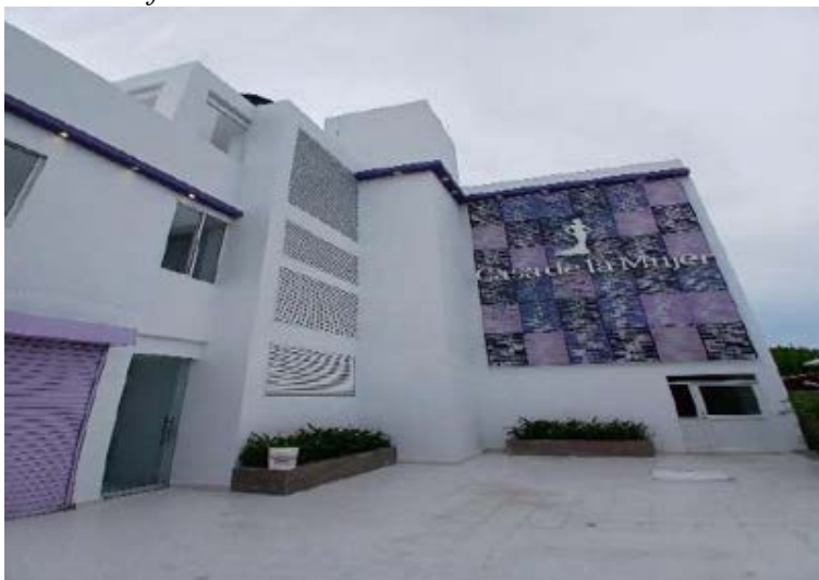
Figura 76. Fachada de la edificación.
