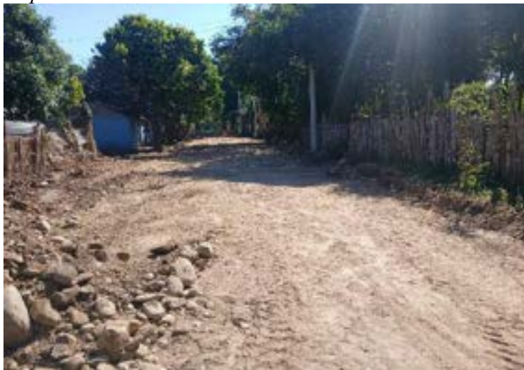
Figura 254. Vía para pavimentar.
