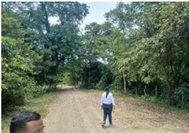
Figura 33. Verificación del estado de subbase.
