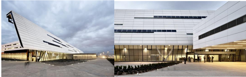
Ilustración 4-5 :Hospital universitario Sant Joan de Reus – Fachada NORTE. Fuente: https://www.archdaily.co/02-279505/hospital-universitario-sant-joan-de-reus-pich-aquilera-architects-corea-and-moran-arquitectura
