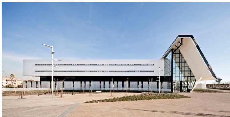
Ilustración 1 :Hospital universitario Sant Joan de Reus – Fachada principal. Fuente: https://www.archdaily.co/02-279505/hospital-universitario-sant-joan-de-reus-pich-aguilera-architects-corea-and-moran-arquitectura
