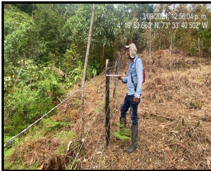
Registro fotográfico cercado perimetral con alambre de púa instalado.
