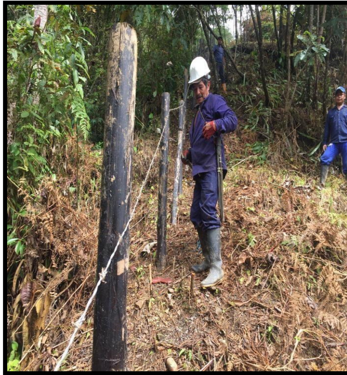
Registro fotográfico cercado perimetral con alambre de púa instalado.
