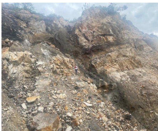
Figura 7. Registró fotográfico estado de la Vía vereda San Joaquín alto y transporte mular realizado.
