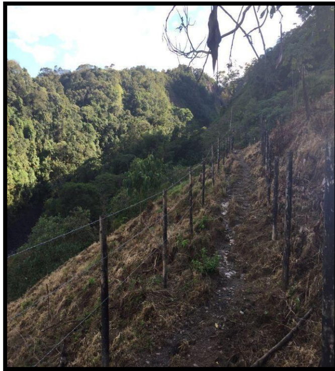
Registro fotográfico camellón adicional requerido con alambre de púa instalado.
