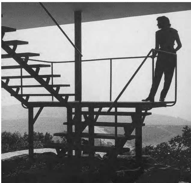
Figura 7. Escalera de acceso en la década del 50. Fotografía, Fuente: Instituto Bardi.
