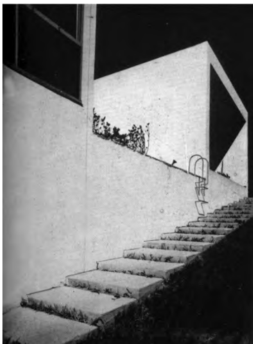
Figura 14. Fachada hacia el mirador. Fuente: Instituto Bardi.
