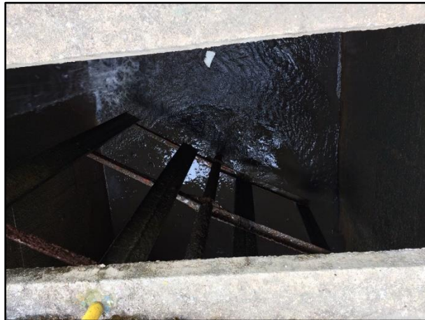
Fotografía 6. Paletas mezcla rápida (Tatiana Zapata, 2019).
