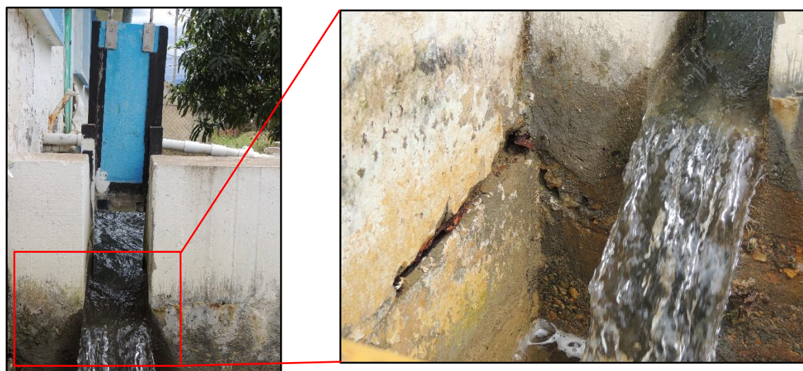
Fotografía 29. Vertedero mezcla rápida hidráulica (Tatiana Zapata, 2019).
