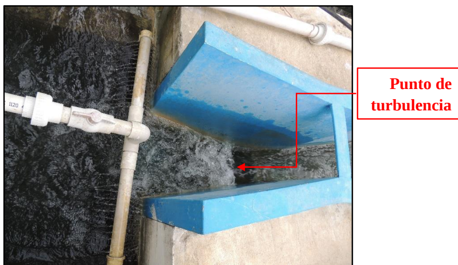
Fotografía 21. Resalto hidráulico - Punto de mayor turbulencia (Tatiana Zapata, 2019).
