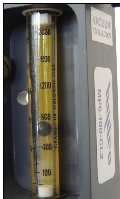
Fotografía 43. Clorador - Ejector (Tatiana Zapata, 2019).
