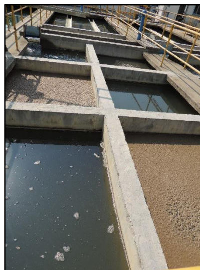
Fotografía 8. Floculadores tipo Cox (Tatiana Zapata, 2019).
