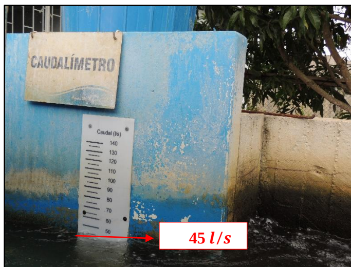
Fotografía 18. Caudalímetro (Tatiana Zapata, 2019).
