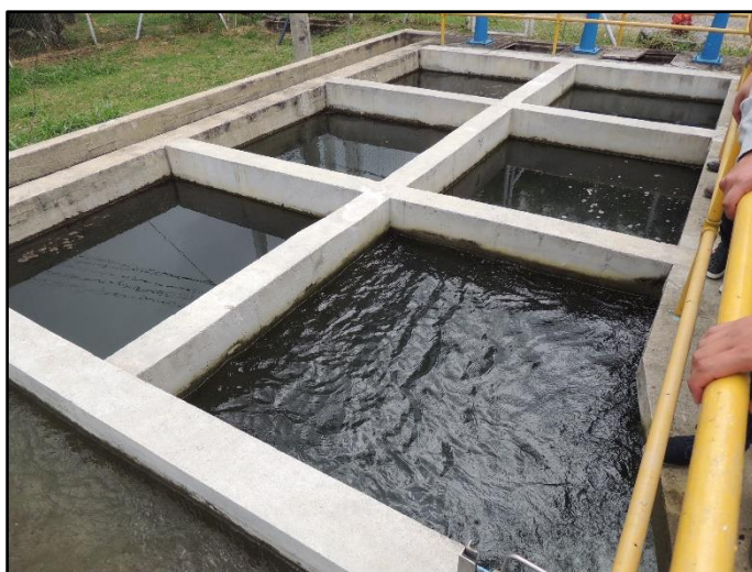
Fotografía 8. Floculadores tipo Cox (Tatiana Zapata, 2019).
