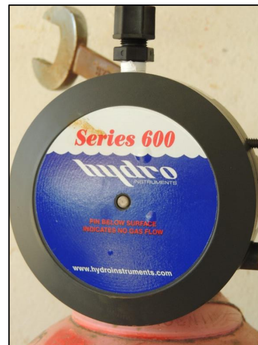
Fotografía 43. Clorador - Ejector (Tatiana Zapata, 2019).
