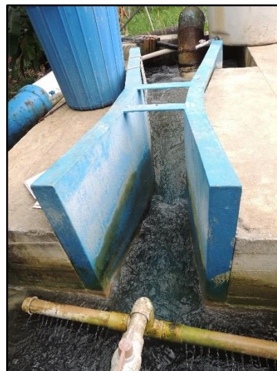
Fotografía 5. Canaleta Parshall (Tatiana Zapata, 2019).
