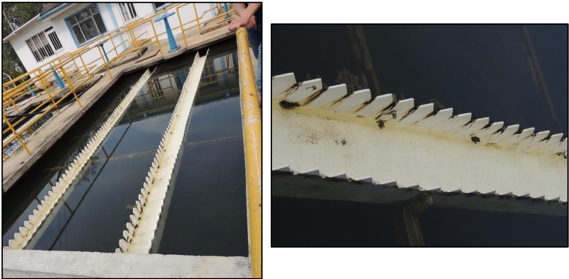
Fotografía 10. Sedimentador de Alta Tasa (Tatiana Zapata, 2019).
