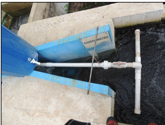
Fotografía 5. Canaleta Parshall (Tatiana Zapata, 2019).
