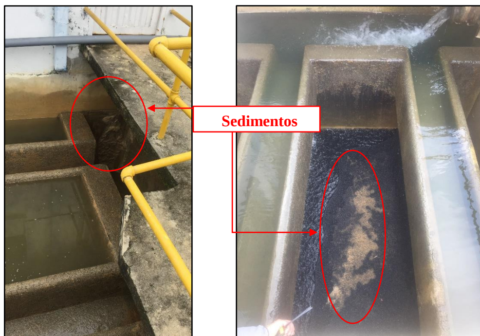
Fotografía 25. Presencia de floc en filtros (Tatiana Zapata, 2019).
