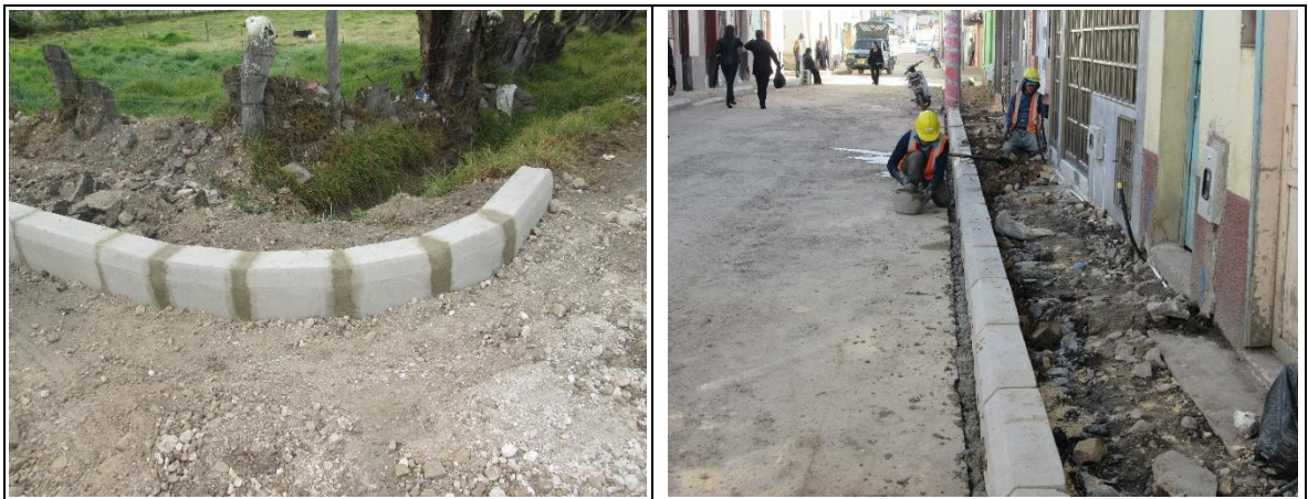
Fotografía 22 y 23. Confinamiento con mortero.
