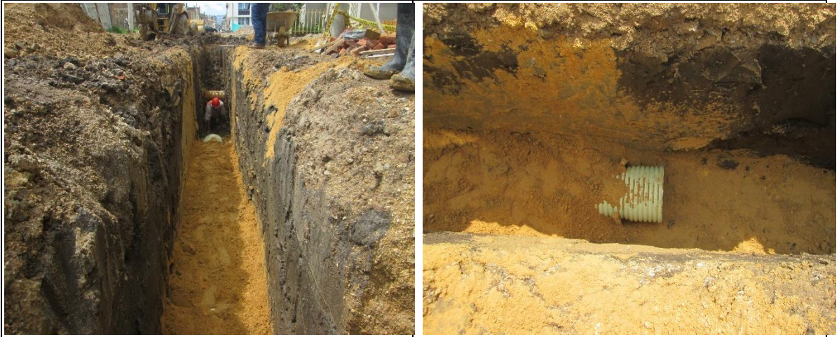
Fotografía 49 Y 50. Recubrimiento de tubería.
