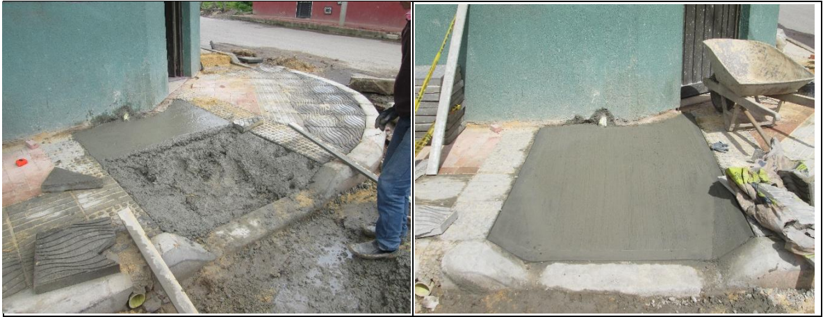
Fotografía 28 y 29. Construcción bahías de acceso.
