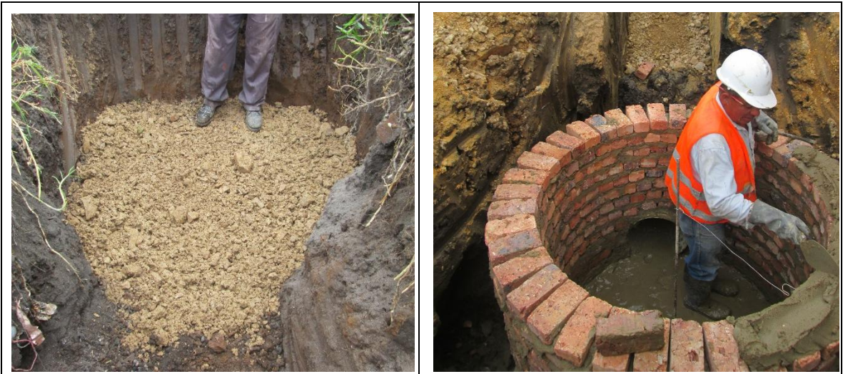
Fotografía 51 Y 52. Construcción de pozos de inspección.
