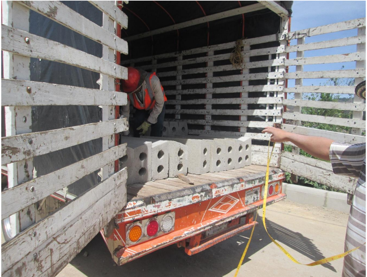
Fotografía 16. Recepción y descargue de sardinel
