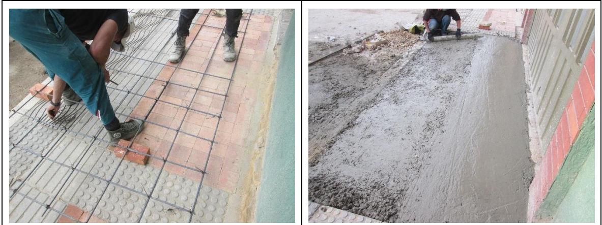
Fotografía 31 y 32. Armadura de hierro e instalación en rampa.
