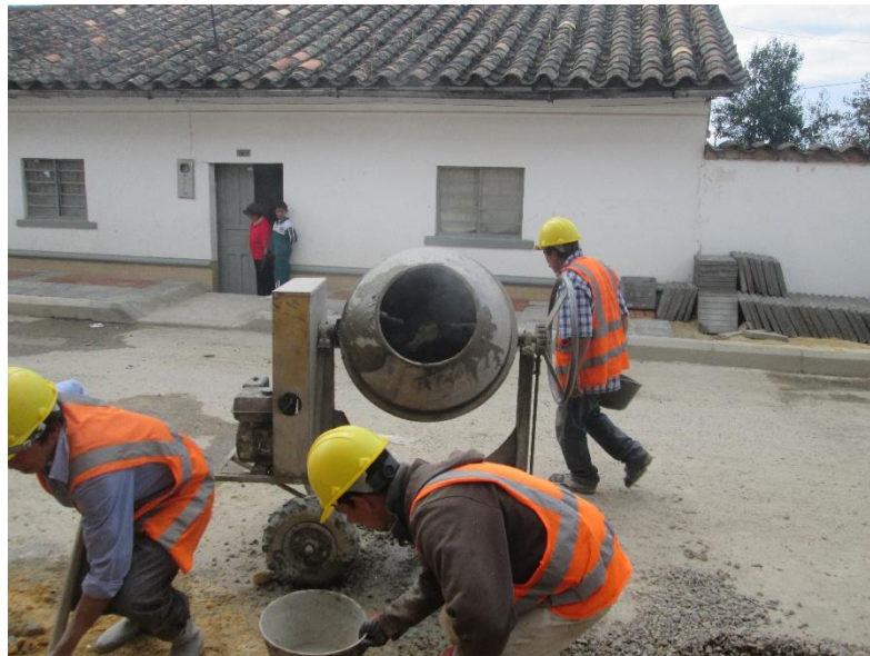
Fotografía 30. Mezcla de concreto.
