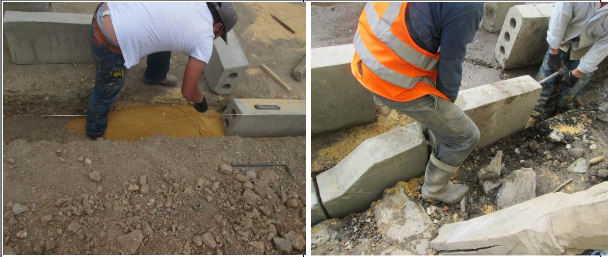
Fotografía 19 y 20. Asentamiento de bordillo
