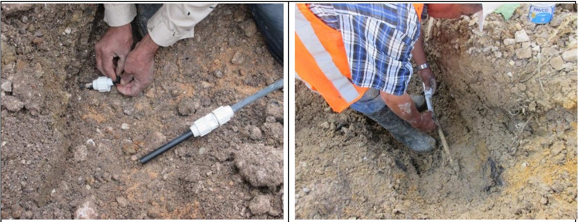
Fotografía 61 y 62. Uniones de reparación.
