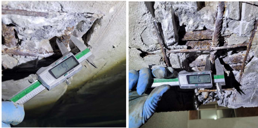
Figura 29. Medición de acero de refuerzo
