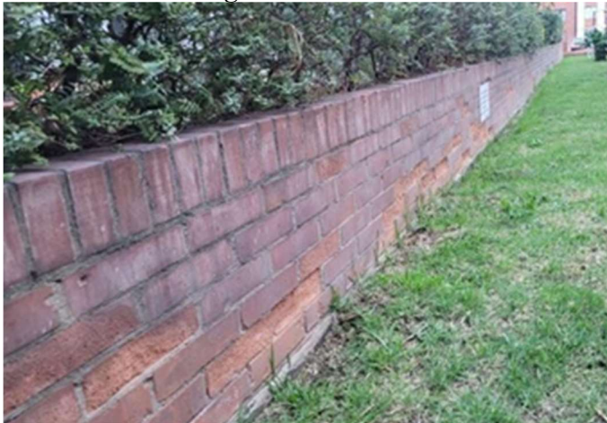
Figura 20. Descascaramiento zonas comunes Torre 6 NIVEL 1
