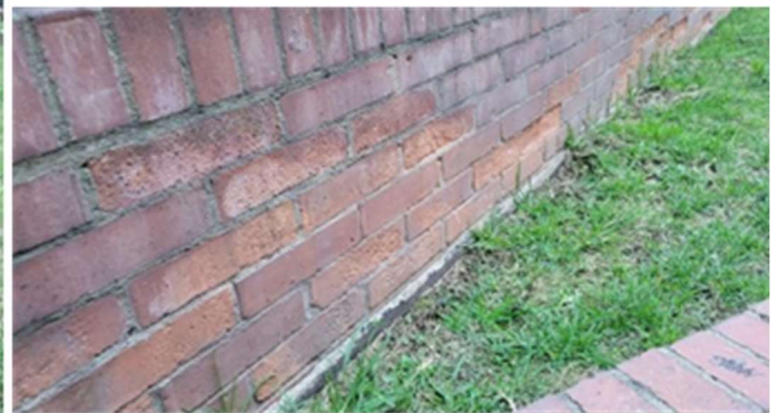
Figura 20. Descascaramiento zonas comunes Torre 6 NIVEL 1
