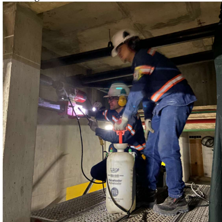
Figura 34. Proceso de extracción de núcleos
