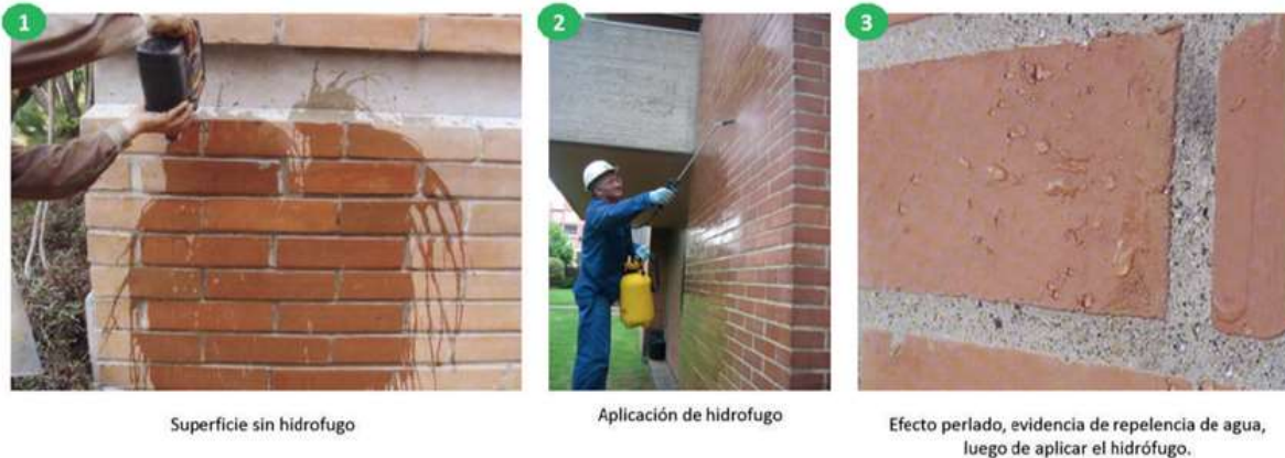
Figura 46. Proceso de aplicación de procesos hidrófugos
