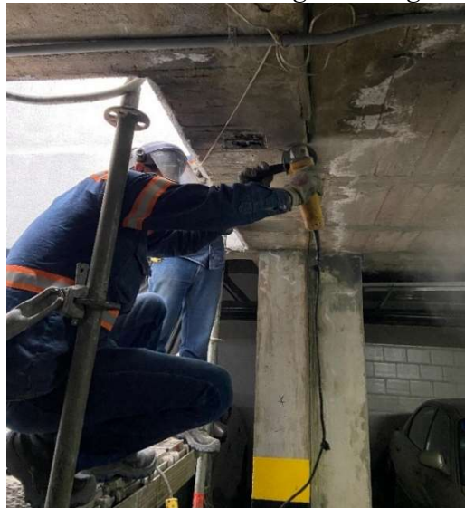
Figura 28. Elaboración de regata en viga aérea 1
