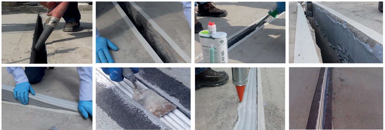
Figura 47. Procedimiento de instalación sellante de juntas
