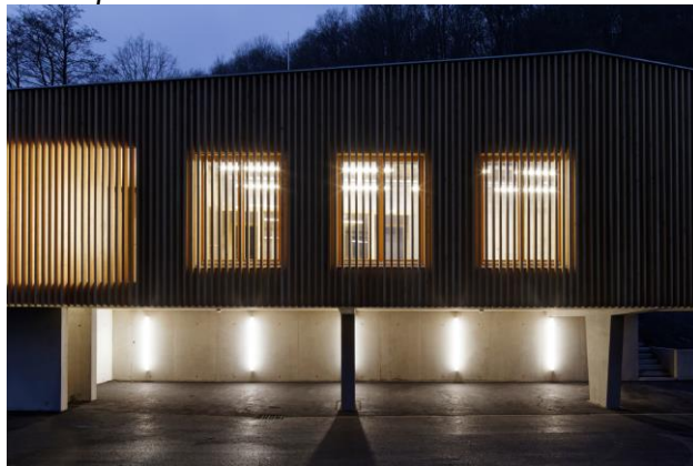
Figura 3. Fachada lateral Edificio
