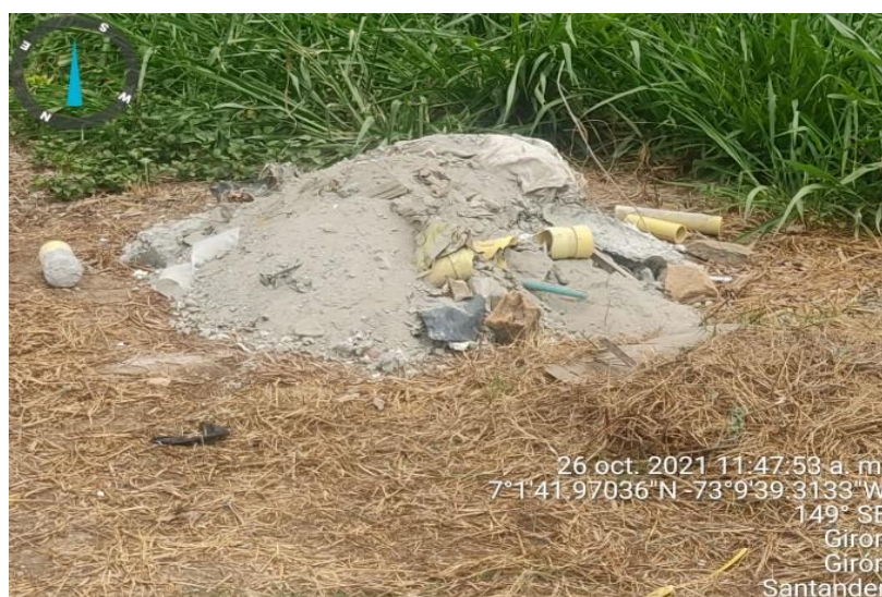
Imagen. 4 Disposición inadecuada de RCD.
