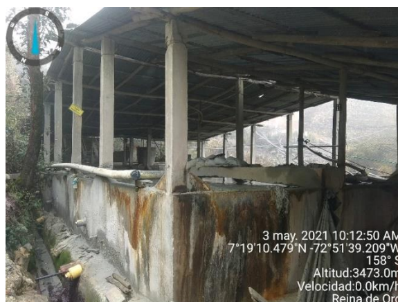
Imagen. 18 Obra Civil Canaleta
