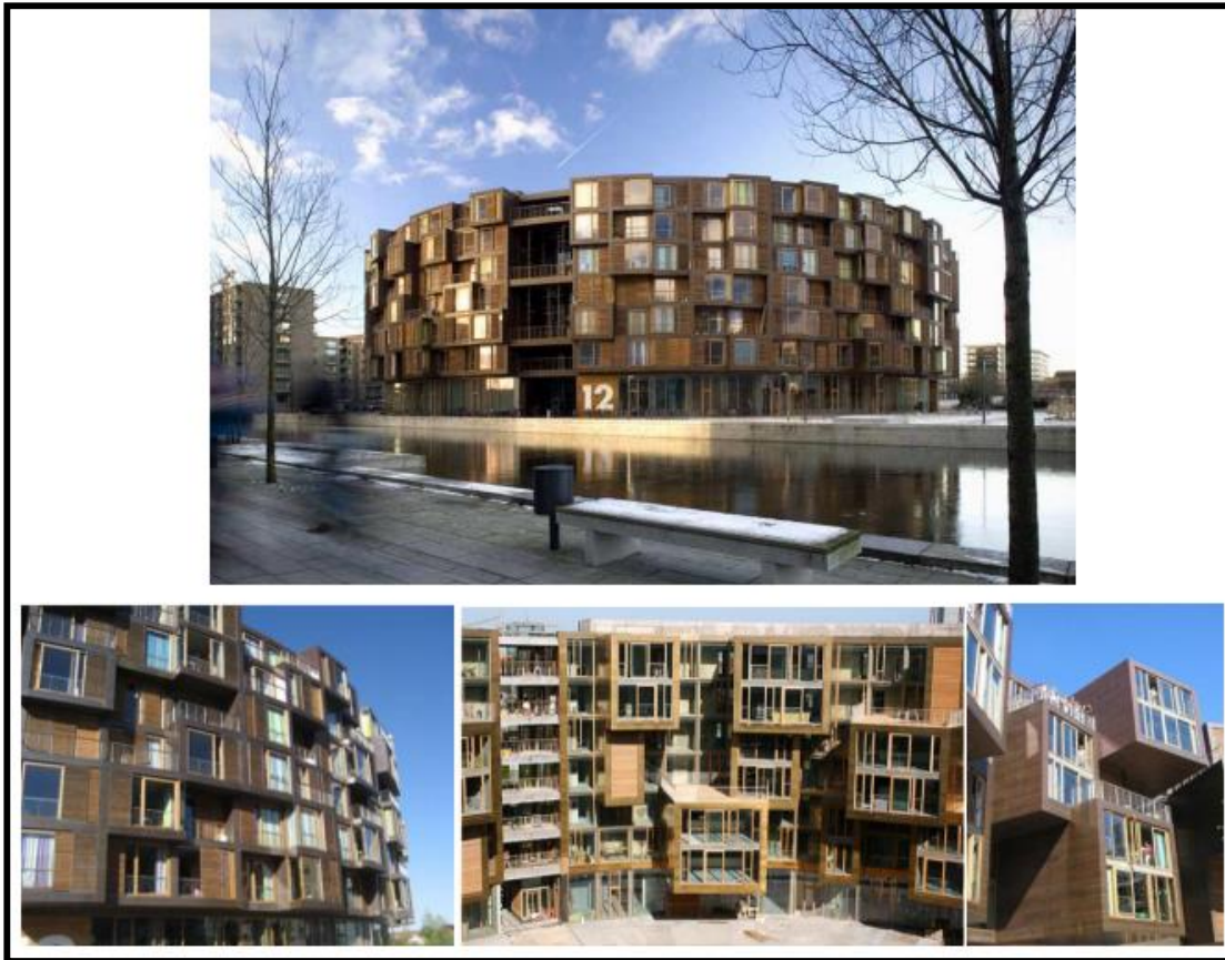
Figura 17. Imágenes de las diferentes fachadas del proyecto Fuente: (Architects, 2014)
