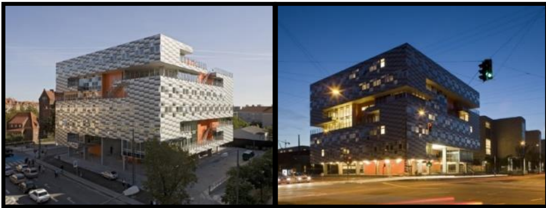
Figura 11. Imágenes de las diferentes fachadas del proyecto.
