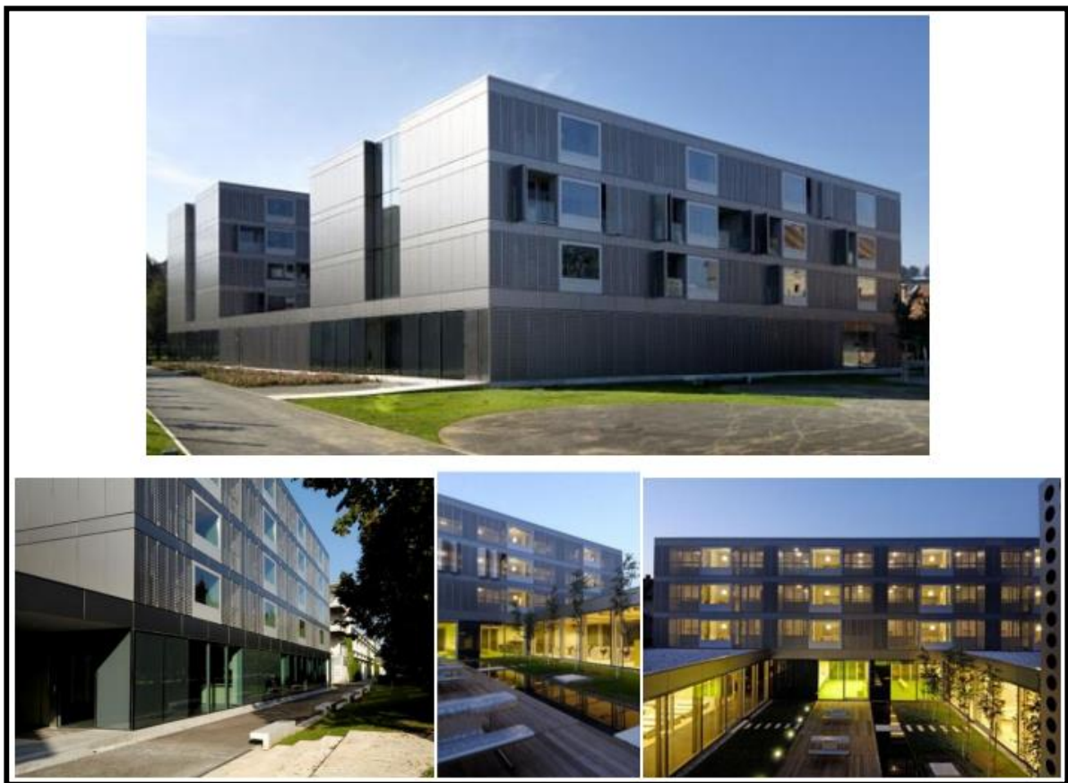
Figura 22. Imágenes de las fachadas internas y externas. Fuente: (Arhitekti, 2006)
