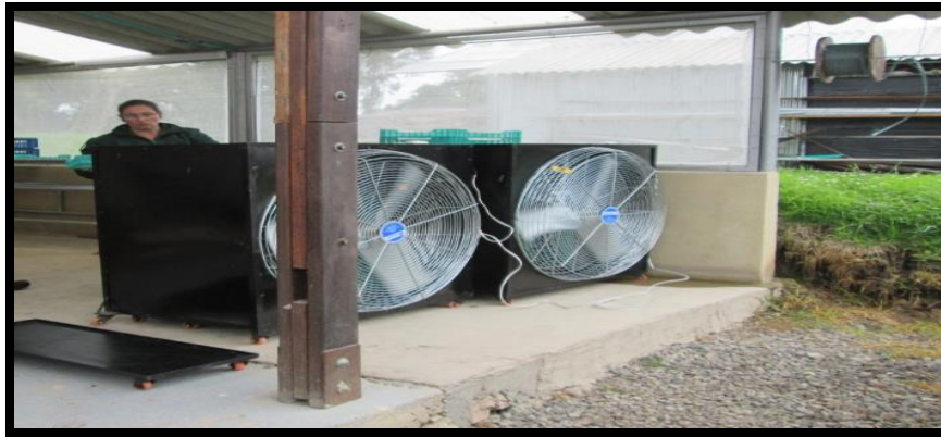
Figura 22. Fotografía detrás del sistema de extracción de humedad excesiva en el arándano después de cosecha, finca Valmar, Chía, Cundinamarca.
