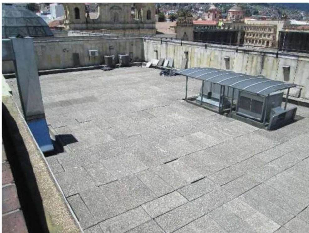
Figura 30. Vista cubierta piso 5, losetas en concreto reforzado. Fuente propia.
