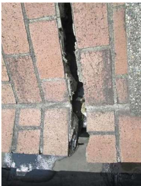
Figura 11. Estado inicial de las cúpulas de cubierta. Fuente propia.
