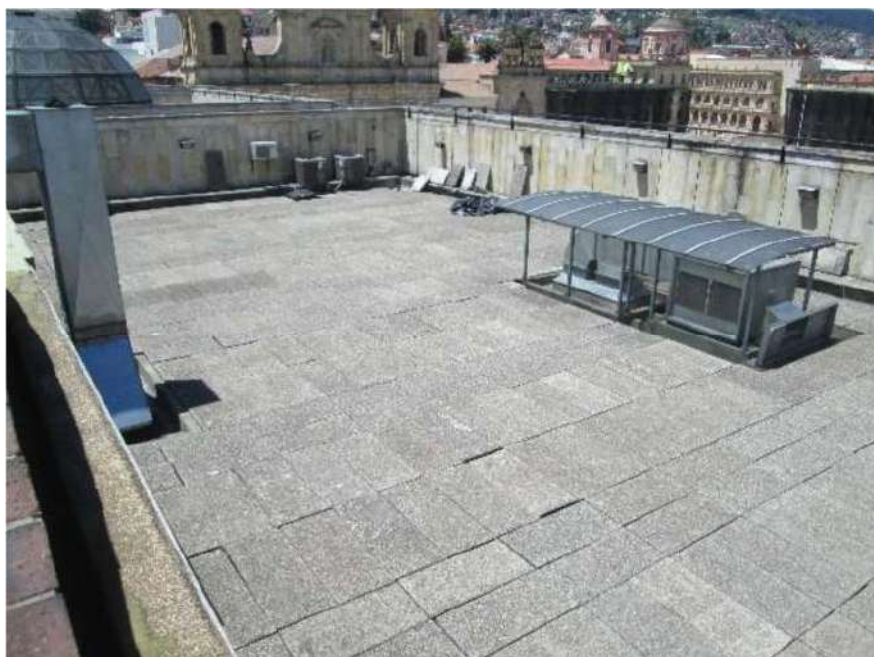
Figura 6. Vista cubierta piso 5, losetas en concreto reforzado. Fuente propia.
