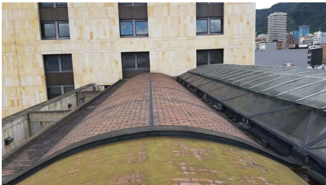
Figura 2. Vista general de la cubierta piso 5, costado oriental. Fuente propia.
