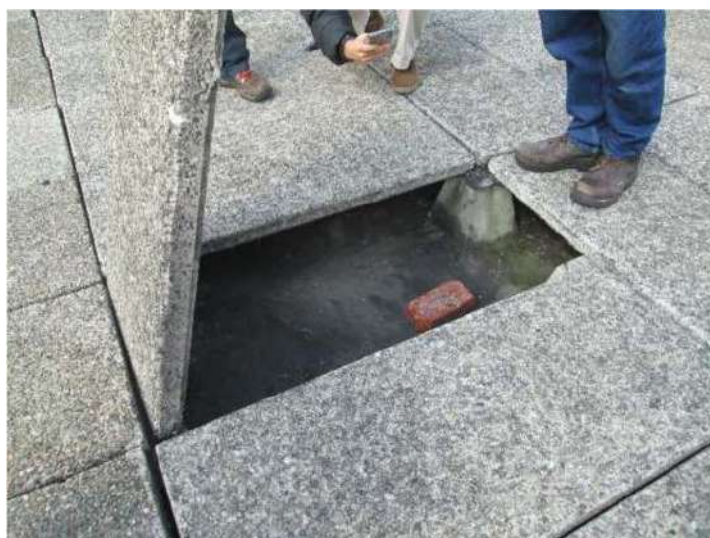
Figura 32. Vista cubierta piso 10, losetas en concreto reforzado y láminas tipo alfajor, helipuerto. Fuente propia.
