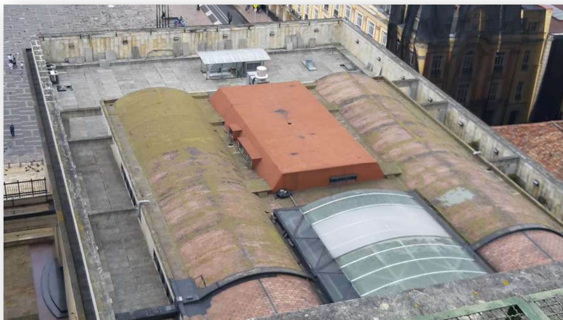
Figura 24. Vigas aéreas de cubierta edificio costado occidental, en evaluación.
