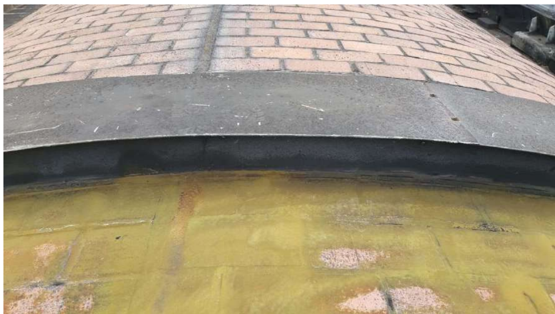
Figura 3. Vista general de la cubierta piso 5, junta de construcción y acabados sobre las bóvedas. Fuente propia.
