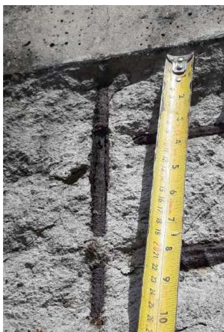
Figura 28. Desprendimiento del concreto, pérdida de sección del acero.
