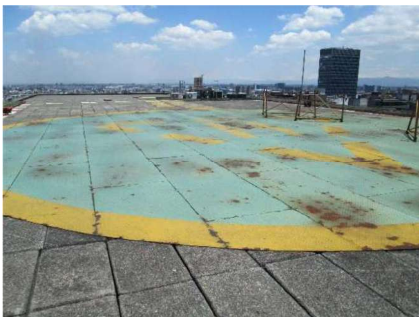
Figura 32. Vista cubierta piso 10, losetas en concreto reforzado y láminas tipo alfajor, helipuerto. Fuente propia.
