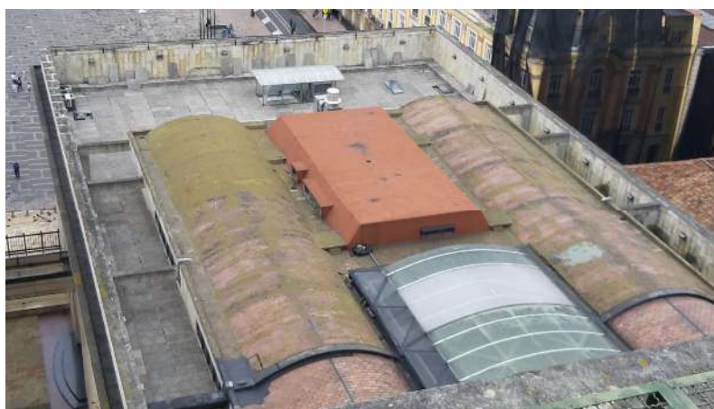
Figura 1. Vista general de la cubierta piso 5, costado occidental. Fuente propia.
