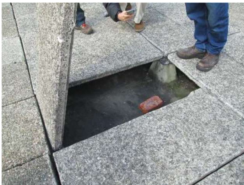
Figura 7. Vista cubierta piso 5, losetas en concreto reforzado. Fuente propia.
