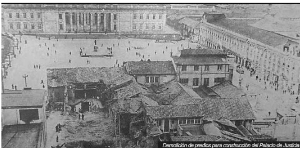
Figura 18. Demolición del Palacio de Justicia antes de 1960. Fuente, El Palacio de Justicia en Bogotá: tres edificios y cinco sedes | Noticias Bogotá | CIVICO.com
