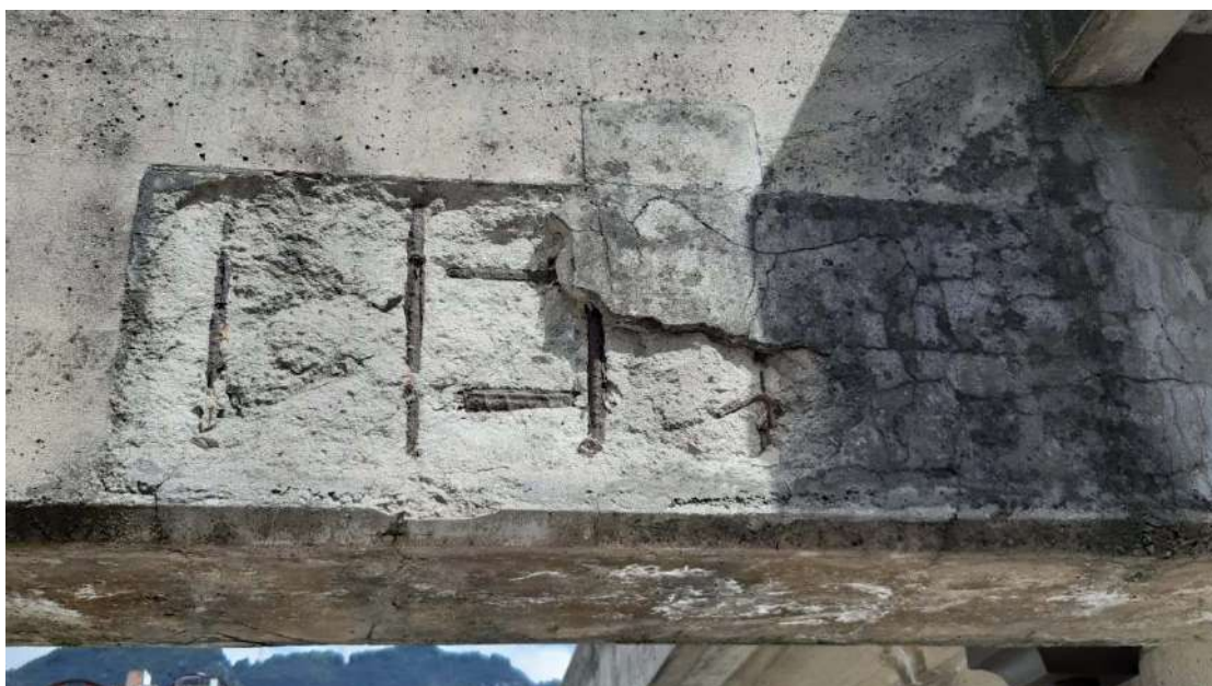
Figura 28. Desprendimiento del concreto, pérdida de sección del acero.
