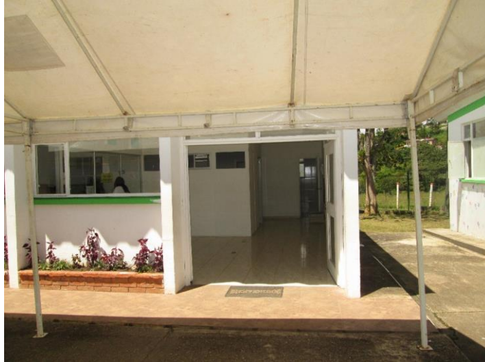
Imagen 4 Hospital regional del Valle de Tenza
