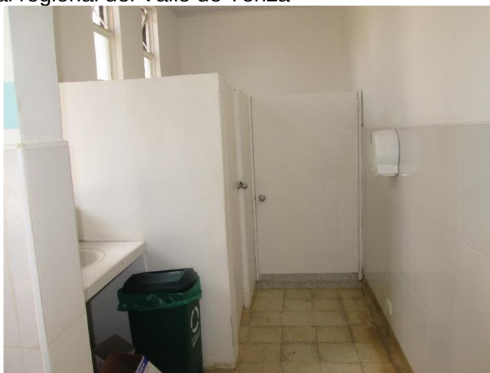
Imagen 1 Hospital regional del Valle de Tenza
