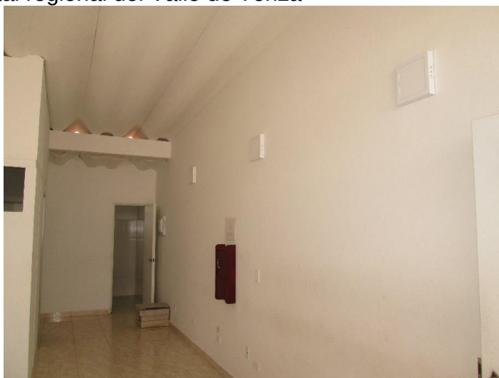
Imagen 3 Hospital regional del Valle de Tenza
