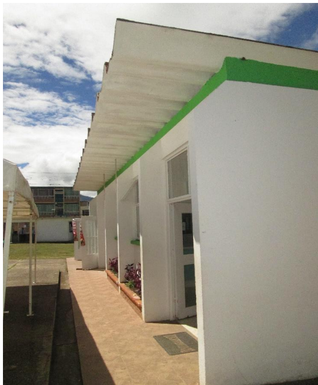
Imagen 2 Hospital regional del Valle de Tenza
