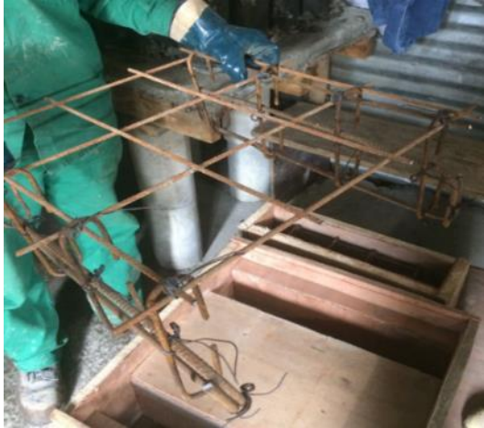
Fotografía 1. Refuerzo Estructural para los modelos.
