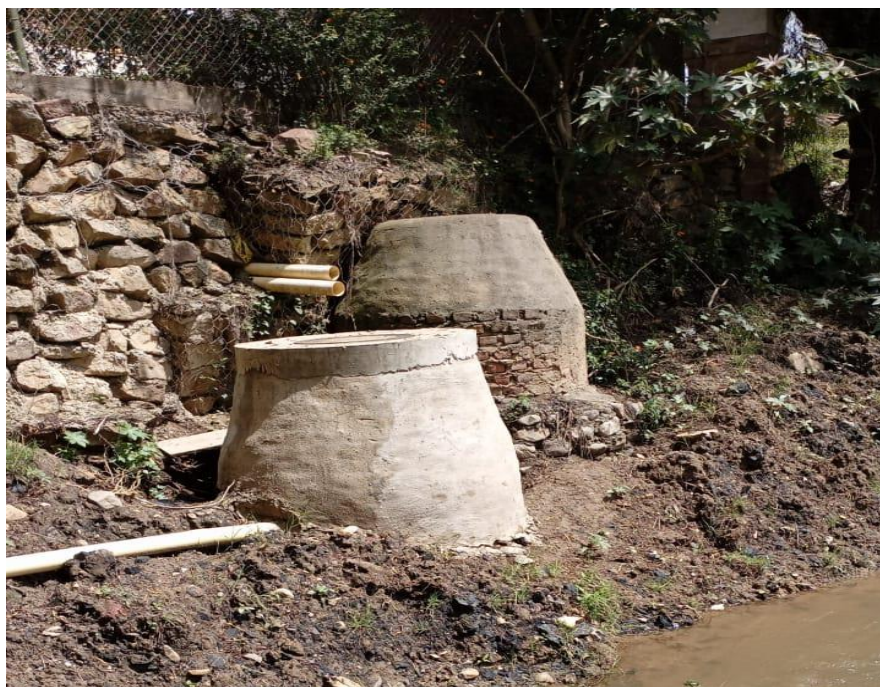
Figura 4. Construcción de Pozos Plan Maestro
