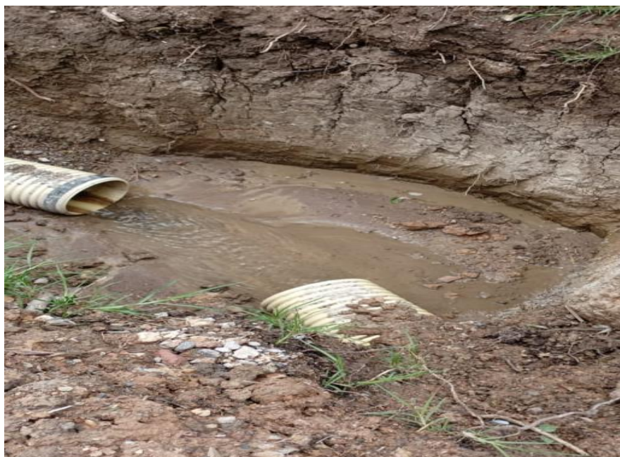
Figura 3. Construcción de Pozos Plan Maestro [3]
