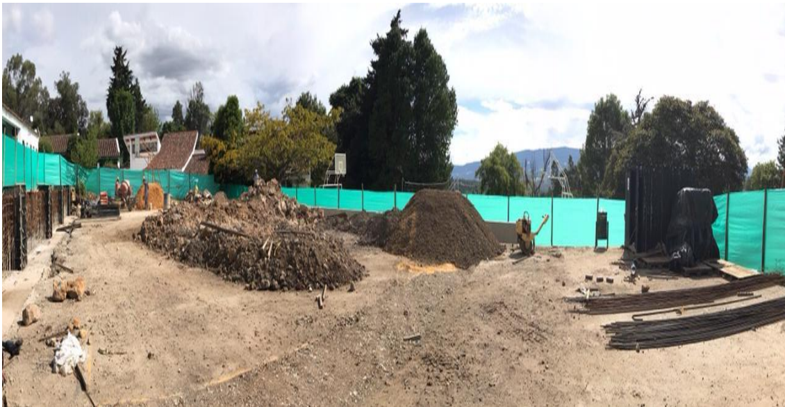
Figura 5. Construcción de Cubierta y Graderías Antonio Nariño [3]
