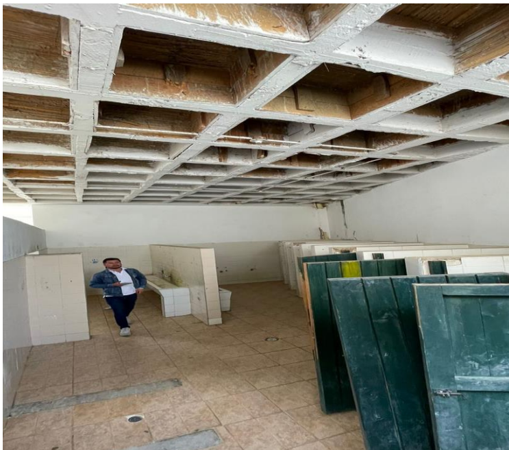
Figura 2. Estado Actual Baños de Hombres
