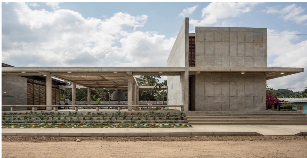
Figura 13. Casa de la Memoria y Espacio Comunitario "Remanso de Paz"-Fachada
