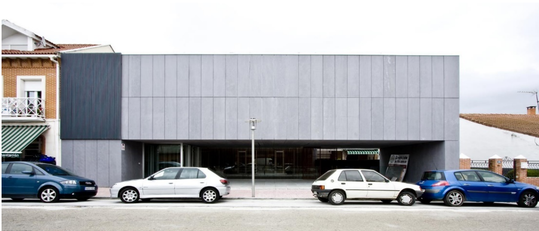
Figura 8. Centro Cívico Municipal de Boecillo-Fachada frontal-Arch Daily
