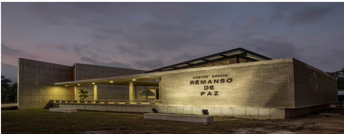
Figura 12. Casa de la Memoria y Espacio Comunitario Remanso de Paz-Fachada Principal- Arch Daily
