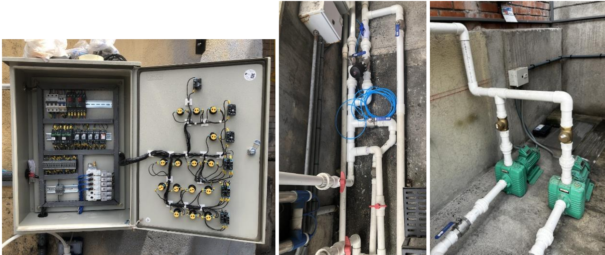
Figura 21. Fotografías de montaje tablero eléctrico y neumático, cableado, tubería, accesorios y motores sistema reúso de PTAR.
