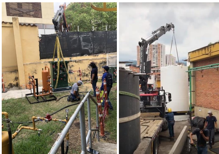
Figura 24. Fotografías acompañamiento instalación sistema de evaporadores de gas licuado de petróleo (GLP), tanques y tubería para uso de PTAR.
