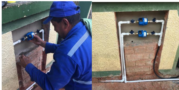
Figura 7. Instalación de medidor, independización.
