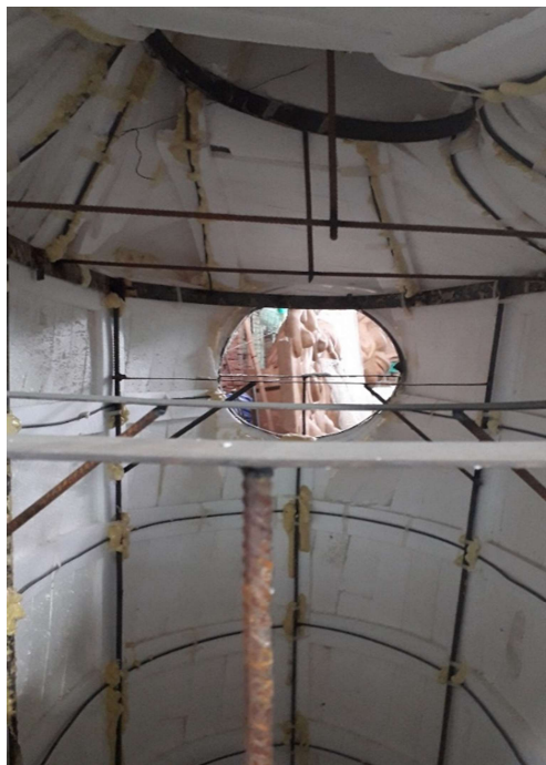
Figura 16: Estructura en hierro
