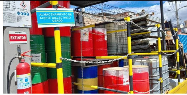
Imagen 10. Almacenamiento de bidones y canecas
