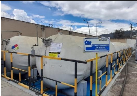
Imagen 9. Dique de almacenamiento
