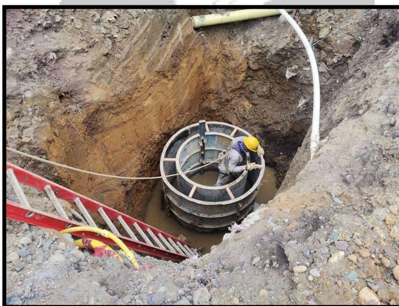
Ilustración 3. Formaleta anillos pozo de inspección ubicado Abs K1+545 calzada derecha.
