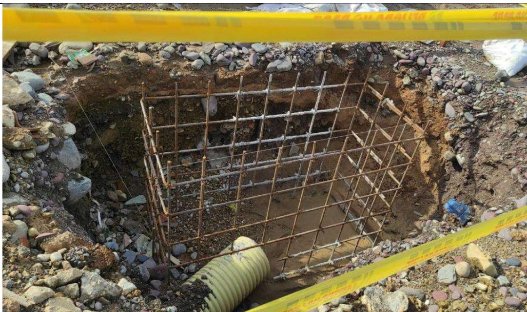
Ilustración 4. Acero de refuerzo sumidero lateral K1+583 calzada derecha.
