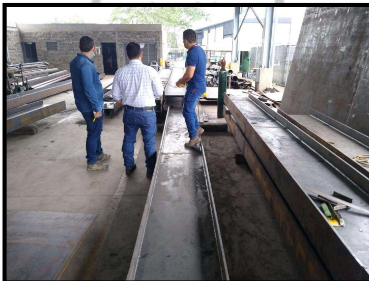
Ilustración 5 y 6. La interventoría verifica el avance de las actividades en taller de estructura metálica vigas de tablero principal, cartelas, riostras, para puente peatonal sector Catumare K1+530.
