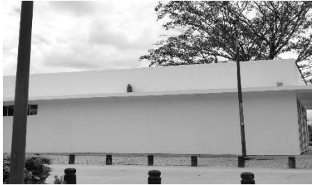
Figura 12. Cilindro en el techo de Casa de la Memoria
