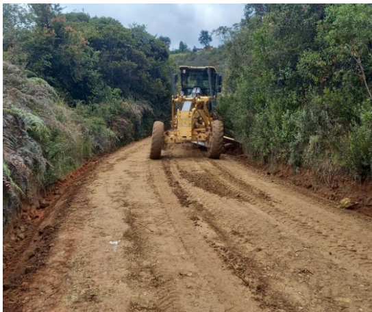
Ilustración 6 Supervisión de Maquinaria Amarilla para el mantenimiento de las vías rurales
