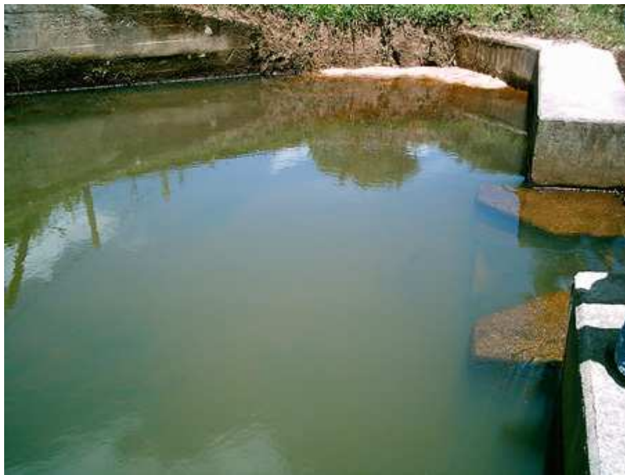
Fotografía 7. Estado de las obras de captación.
