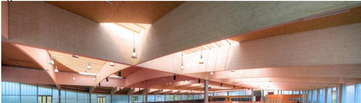
Figura 11. Foto detalle cubierta
