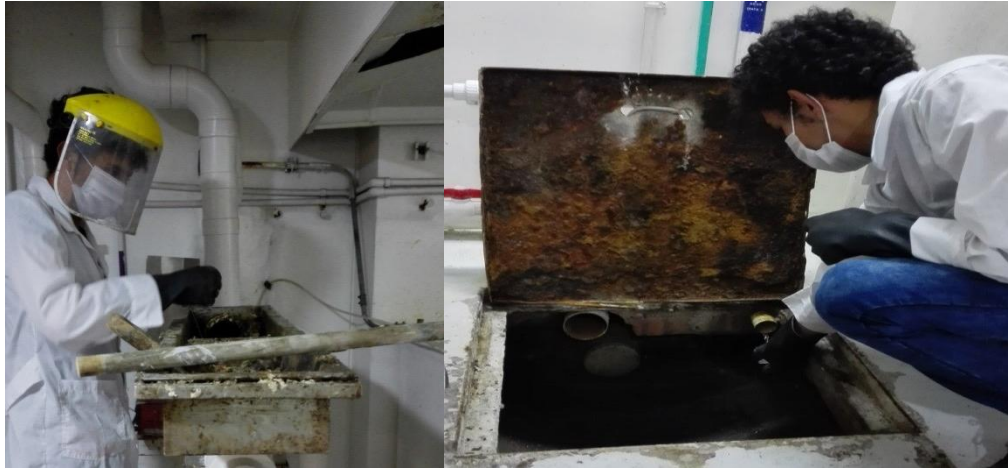
Fotografía 8. Puntos de muestreo (Entrada: fotografía de lado izquierdo, Salida: fotografía de lado derecho).
