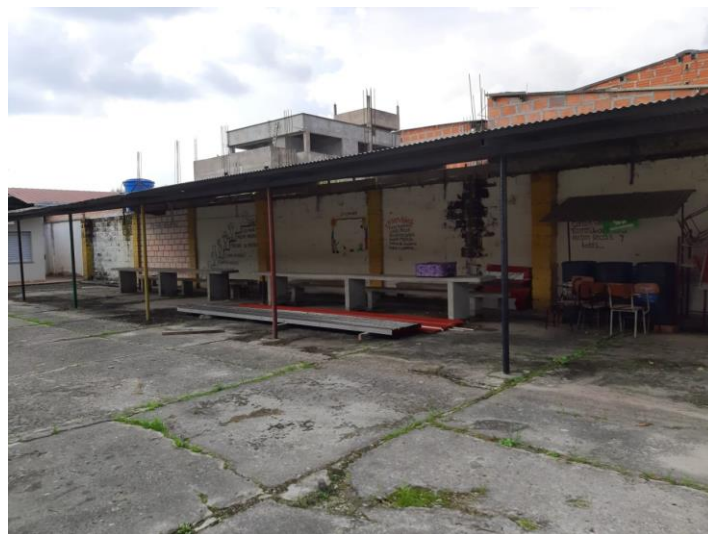
Figura 31. Cubierta y comedores
