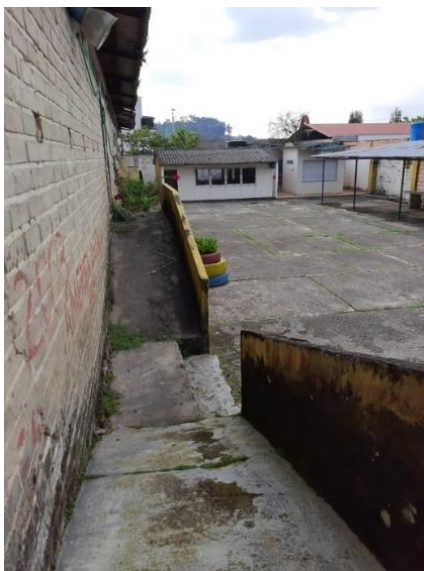
Figura 33. Rampas y escaleras de acceso a las aulas
