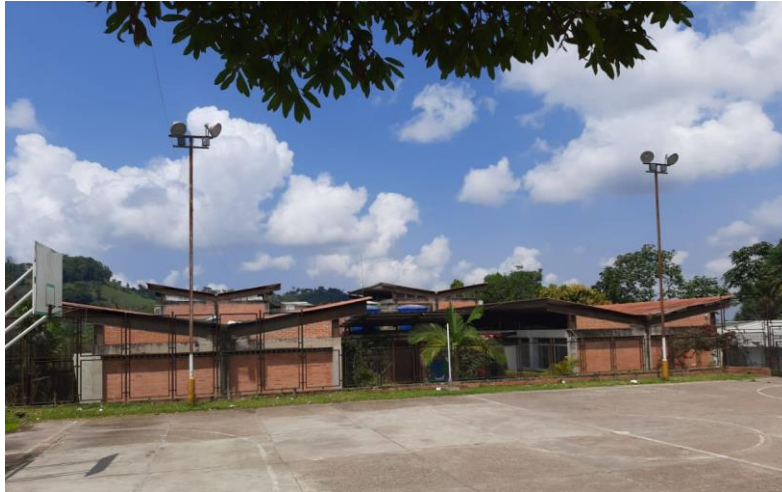
Figura 76. Acceso a la sede
