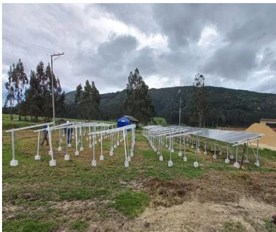
Ilustración 4 Construcción mesas SSFV 73.6 Kwp
