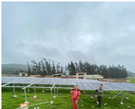
Ilustración 5 Instalación paneles solares 73.6 Kwp
