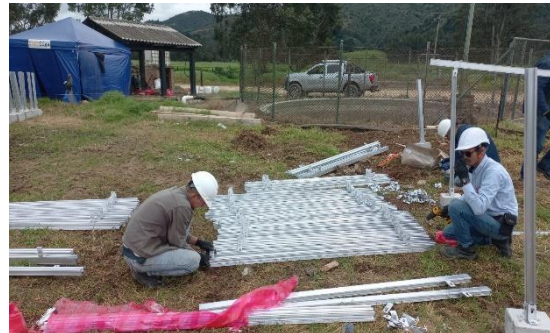
Ilustración 3 Construcción SSFV 73.6 Kwp
