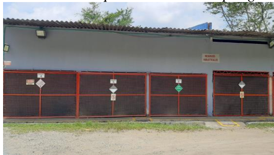
Figura 3. Bodegas de almacenamiento temporal de residuos peligrosos
