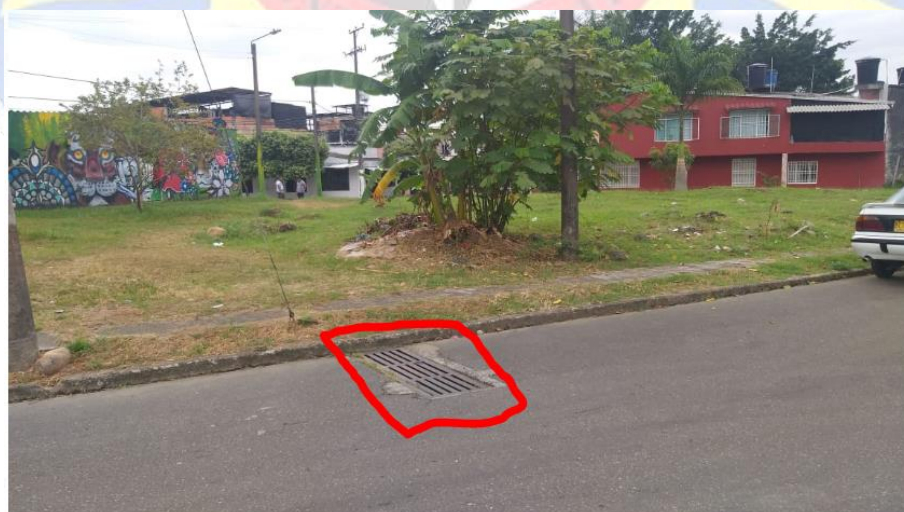
Fotografía 2. localización red de alcantarillado
