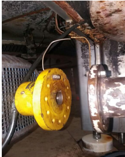
Ilustración 27. Acople de transmisión llenadora
