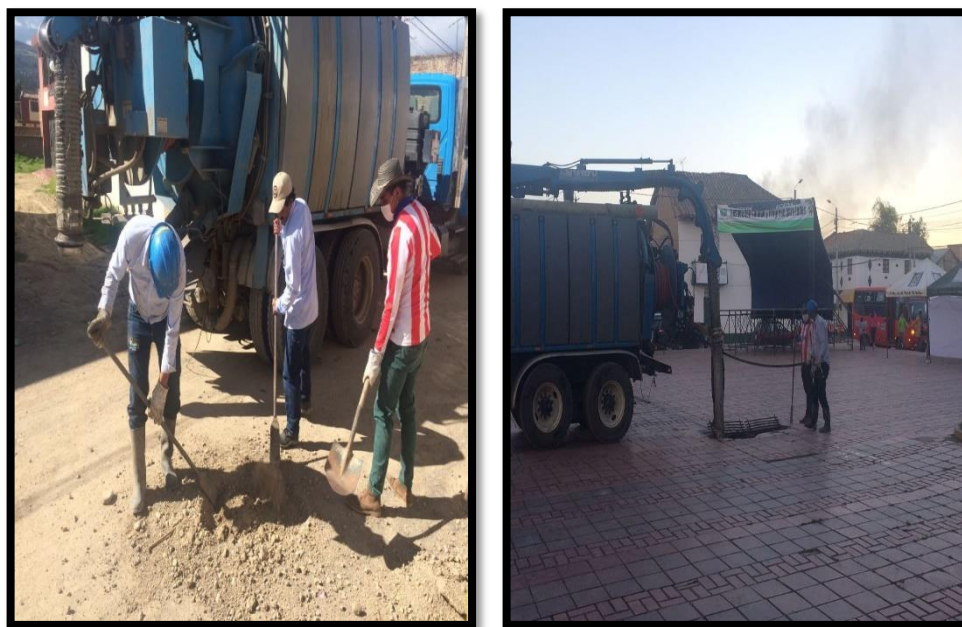
Imagen 58. Limpieza de alcantarillado con la maquinaria camión de hidro-succión
