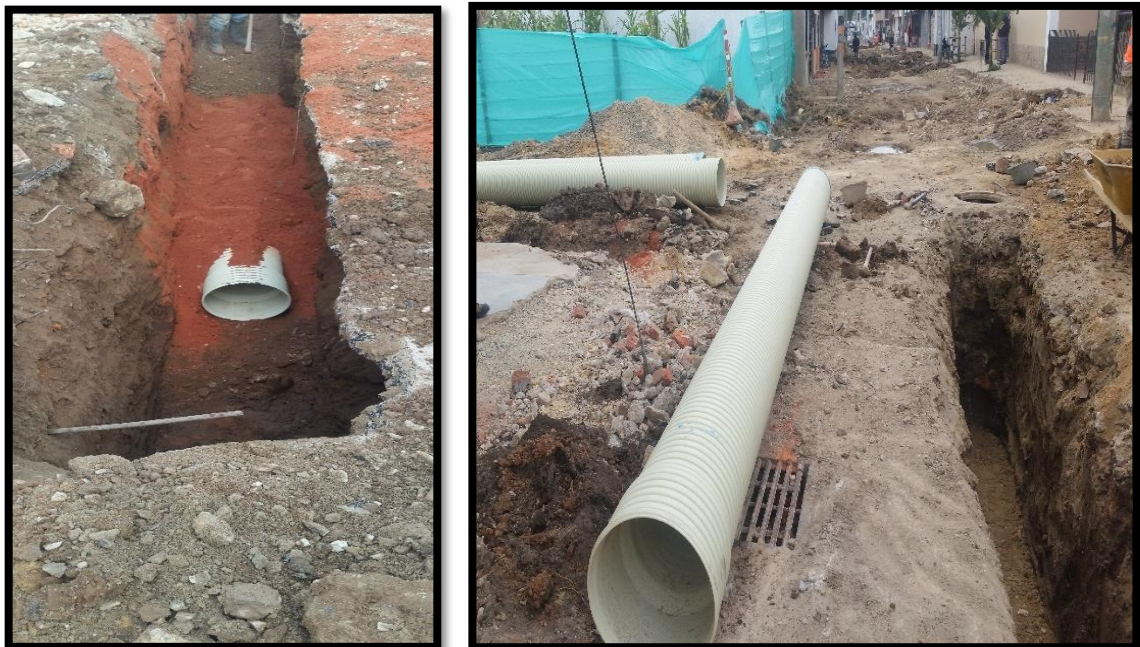
Imagen 34. Instalación de tubería PVC 16" en obra
