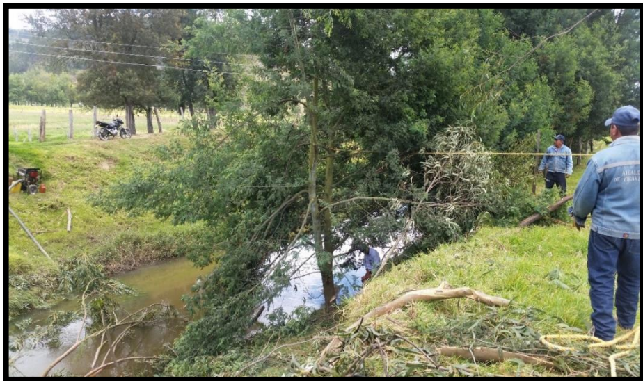
Imagen 57. Limpieza de material en el talud del jarillon del río Chiquito
