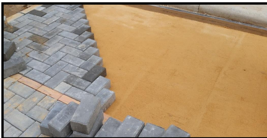
Imagen 43. Instalación de pavimento articulado
