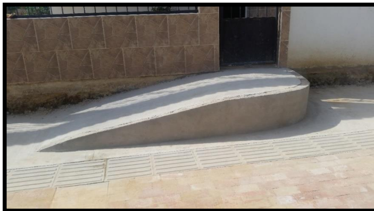
Imagen 49. Rampa de acceso a una casa
