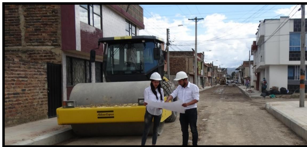
Imagen 7. Visita a obra
