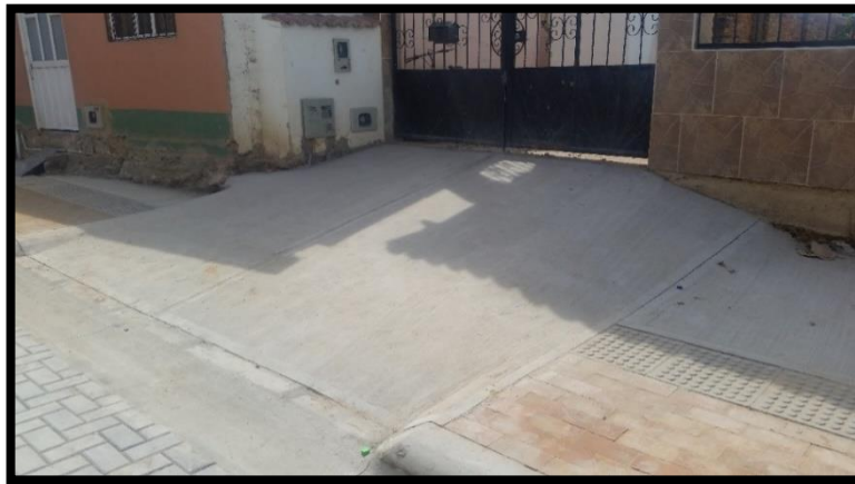
Imagen 47. Rampas para acceso de garajes
