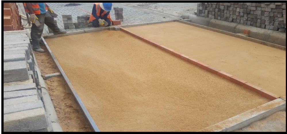
Imagen 36. Instalación del pavimento articulado
