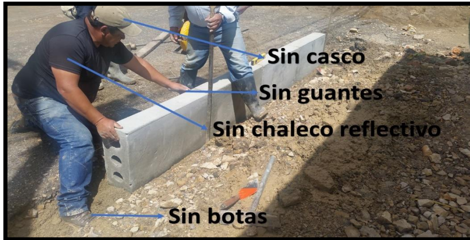
Imagen 44. Elementos de protección personal en obra
