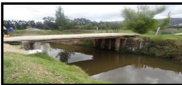
Imagen 32. Puente El Desbabe vereda Tintal
