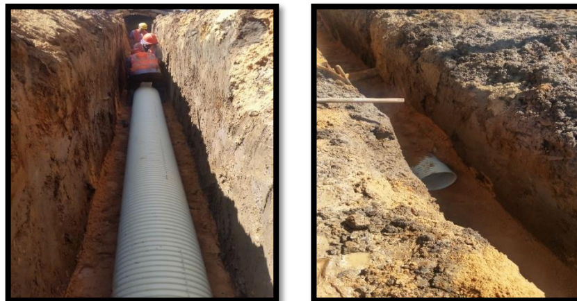
Imagen 42. Instalación de tubería PVC 16" en obra
