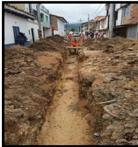
Imagen 9. Instalación de tubería PVC 16"
