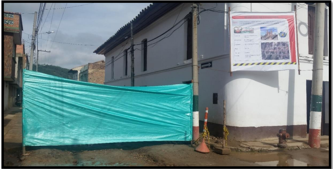
Imagen 39. Señalización de la obra LPMF-002-2016
