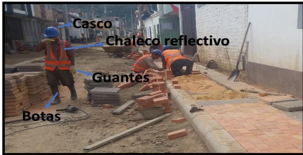
Imagen 38. Elementos de protección personal en obra
