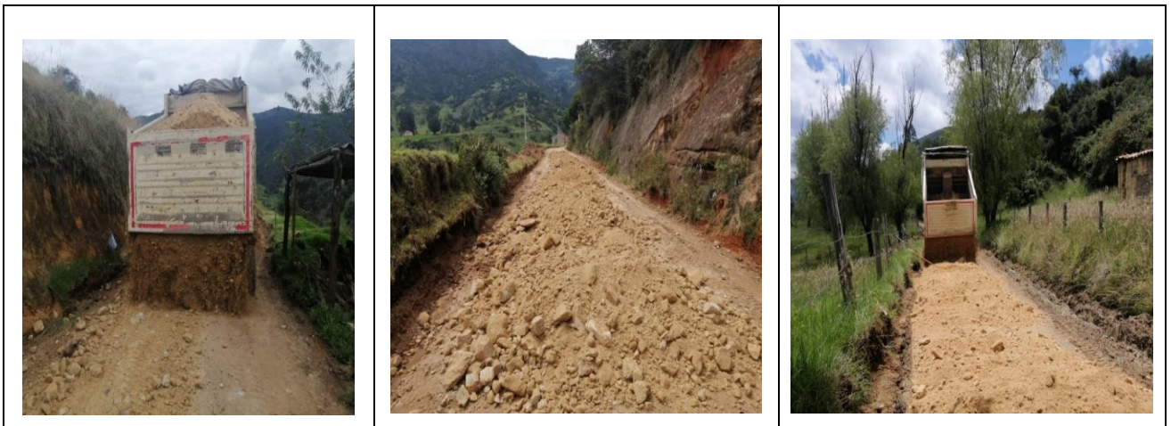
Figura 27. DESCARGUE DE MATERIAL
