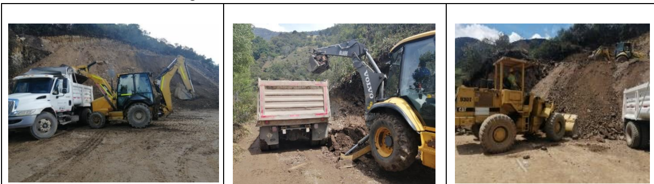
Figura 24. CARGUE DE MATERIAL
