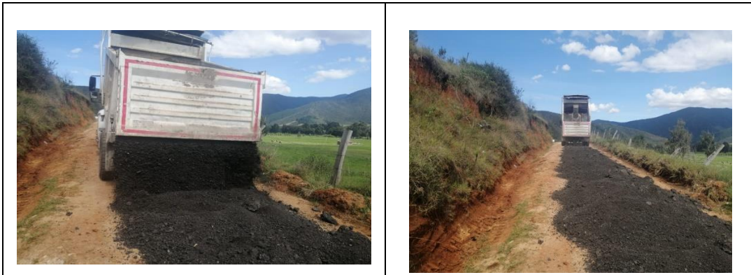
Figura 33. DESCARGUE DEL MATERIAL
