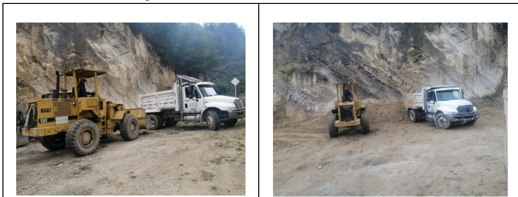
Figura 38. CARGUE DE MATERIAL
