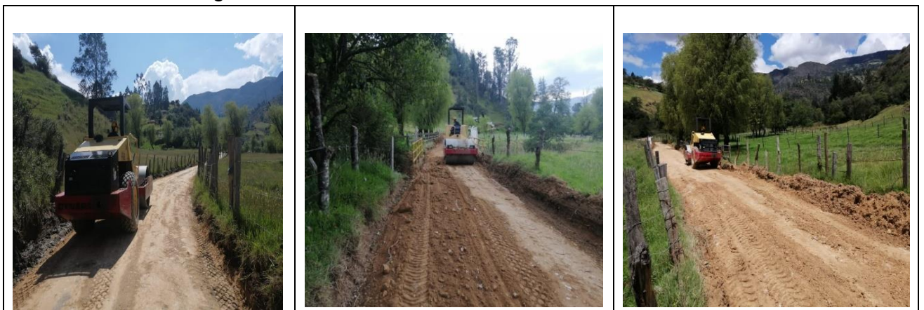
Figura 29. COMPACTACIÓN DE MATERIAL
