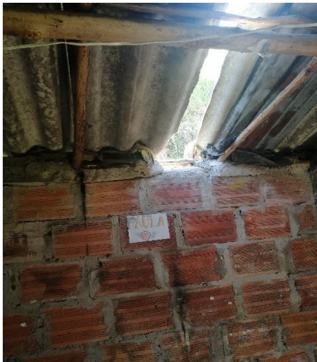
Figura 11. Cubierta de la vivienda
