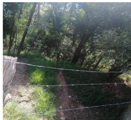
Figura 19. Alcantarilla zona de arriba
