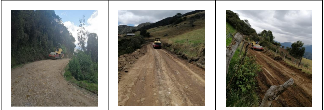
Figura 26. COMPACTACION DEL SUELO
