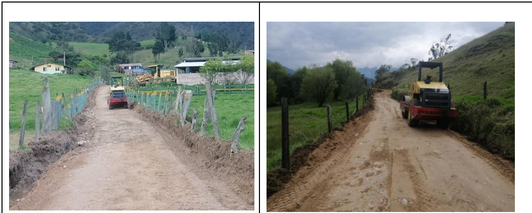
Figura 41. COMPACTACION DE MATERIAL
