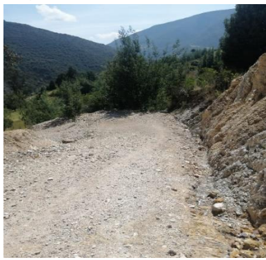
Figura 17. Ampliación de vía
