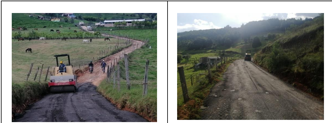
Figura 35. SELLADO DE MATERIAL
