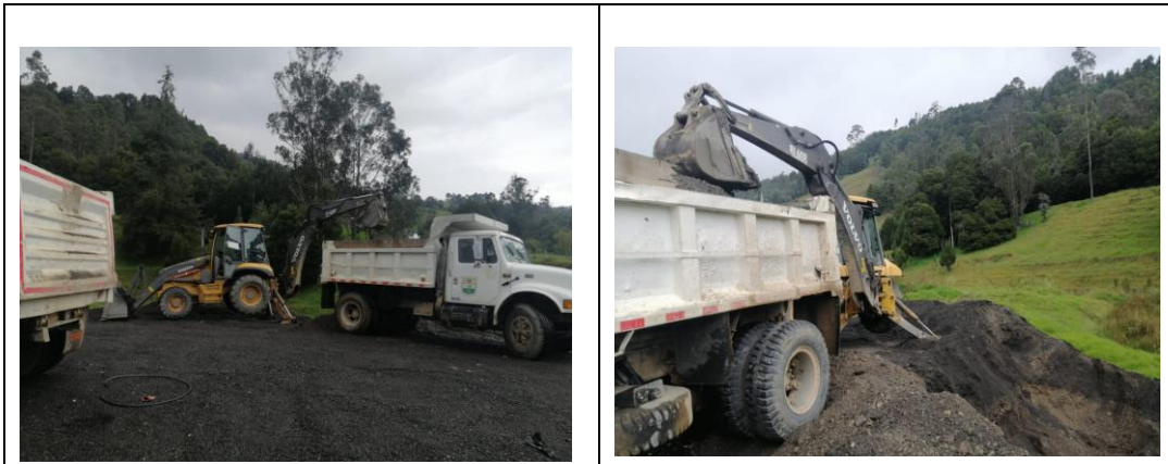
Figura 32. CARGUE DE MATERIAL RETIRADO DEL PAVIMENTO FLEXIBLE
