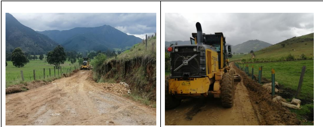
Figura 40. REPLANTEO DE MATERIAL
