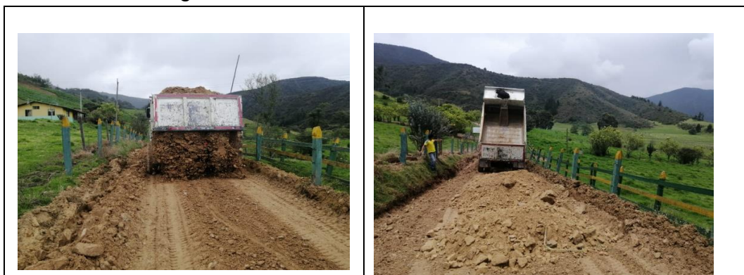
Figura 39. DESCARGUE DEL MATERIAL
