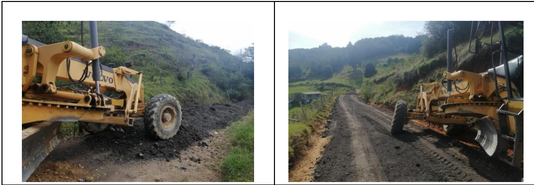
Figura 34. EXTENSIÓN DE MATERIAL
