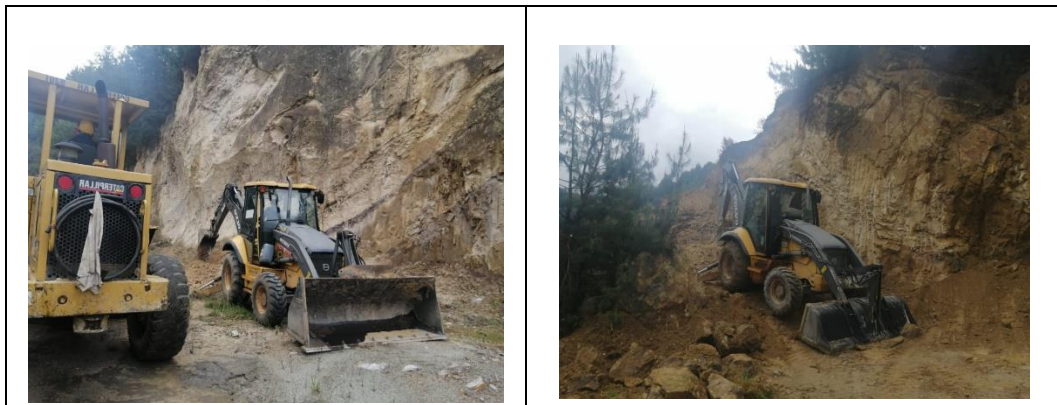
Figura 37. EXTRACCION DE MATERIAL
