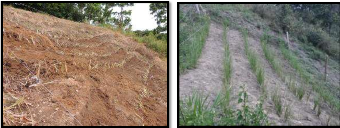
FIGURA 4. TALUD CON VETIVER Y MICORRIZAS DURANTE LA SIEMBRA Y 4 MESES DESPUÉS.
