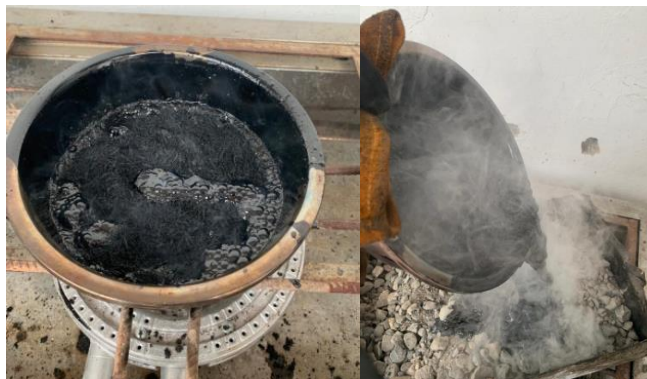
Figura 27. Adicion del cemento asfaltico modificado con el agregado de grano de caucho a la mezcla.
