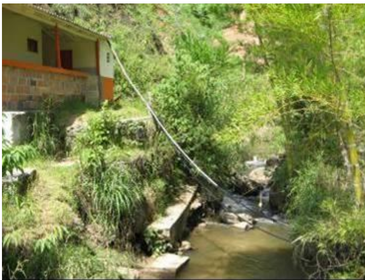
Fotografía 6. Vivienda sobre el borde de la quebrada Pozo en la parte baja
