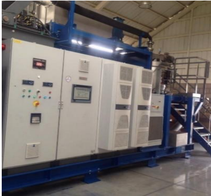
Figura 11. Proceso de destrucción de medicamento. Fuente propia
