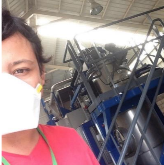
Figura 9. Proceso de destrucción de medicamento. Fuente propia
