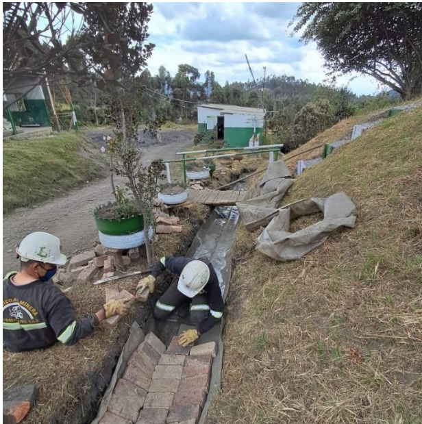
Ilustración 17. Desarrollo de cunetaje con ladrillo y material reutilizado (Ducto de ventilación)
