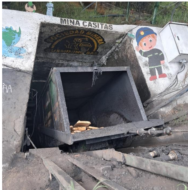
Ilustración 3. Entrada de sistema de transporte a bocamina
