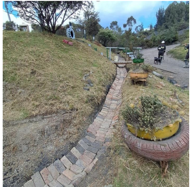
Ilustración 17. Desarrollo de cunetaje con ladrillo y material reutilizado (Ducto de ventilación)
