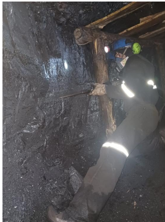
Ilustración 4. Arranque con martillo neumático para extracción de material
