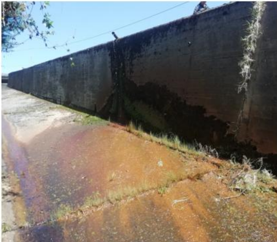
Fotografía. 38. Afloramiento de maleza a través de la junta.
