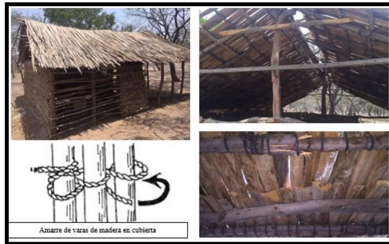
Figura 25. Cubierta de la vivienda Wayuu
