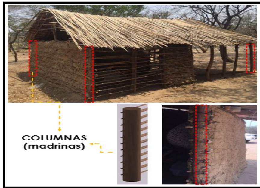
Figura 28. Columnas de la vivienda Wayuu
