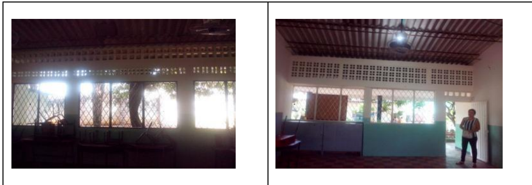
Foto 17. Ventana y puerta en estructura metálica existe en la edificación de la Institución Educativa Escuela Ciudad Jardín
