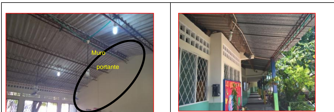
Foto 2. Muros laterales o divisorios que funcionan como muro de carga y muros fachadas que funcionan como muros no estructurales en las aulas de la Institución Educativa Escuela Ciudad Jardín
