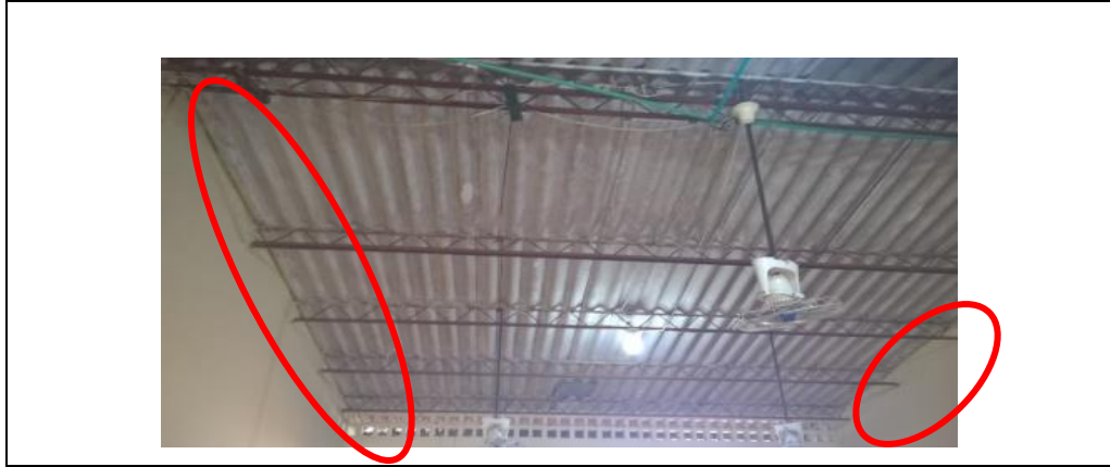
Foto 8. Cerchas en estructura metálica, soporte para la cubierta en el interior de los salones y en el corredor de la Institución Educativa Escuela Ciudad Jardín
