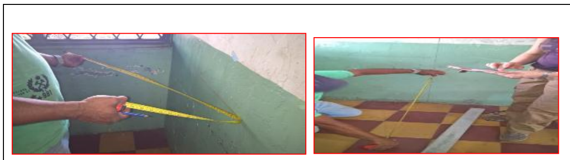
Foto 23. Medición de escuadra muros en las aulas
