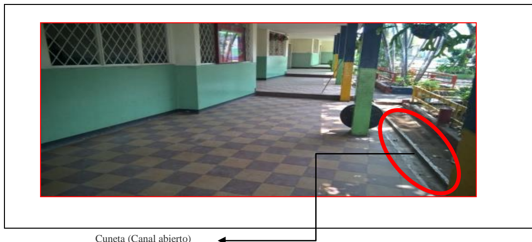
Foto 15. Canal abierto o zanja en concreto existente para el desagüe de A-LL superficiales y de cubierta
