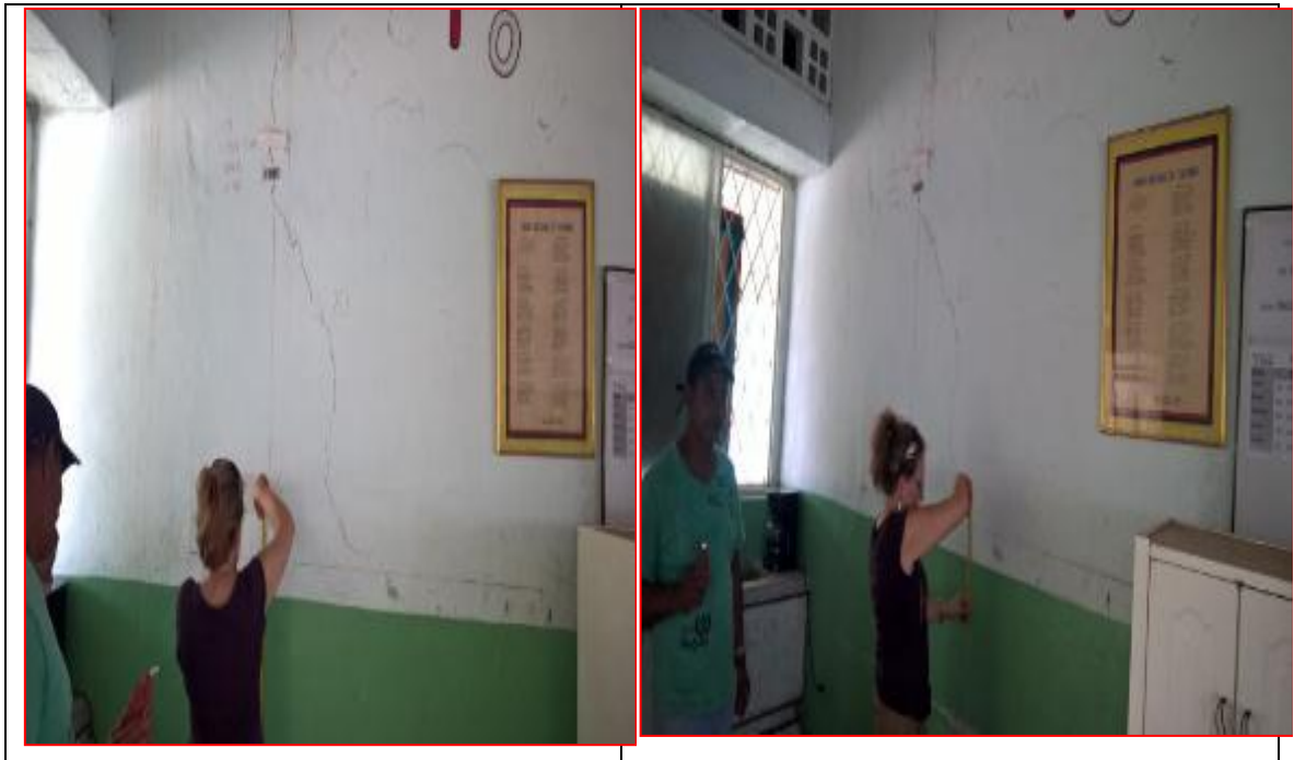
Foto 22. Medición del nivel del muro de las aulas en la escuela
