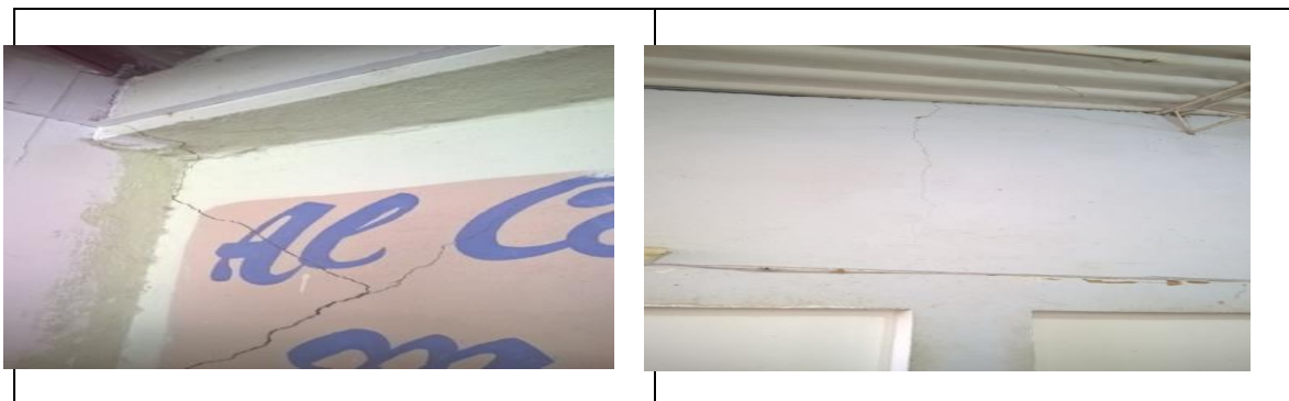
Foto 5. Vigas aéreas construidas en el restaurante de la edificación de la Institución Educativa Escuela Ciudad Jardín
