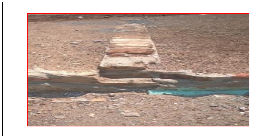
Foto 1. Cimentación en concreto ciclópeo existente en la edificación de la Institución Educativa Escuela Ciudad Jardín
