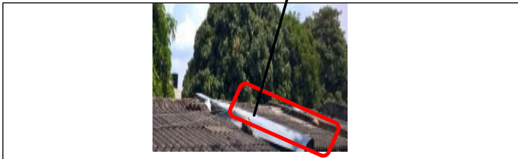
Foto 14. Recubrimiento en lámina lisa galvanizada en los muros laterales divisorios de las aulas de la Edificación de la Institución Escuela Ciudad Jardín
