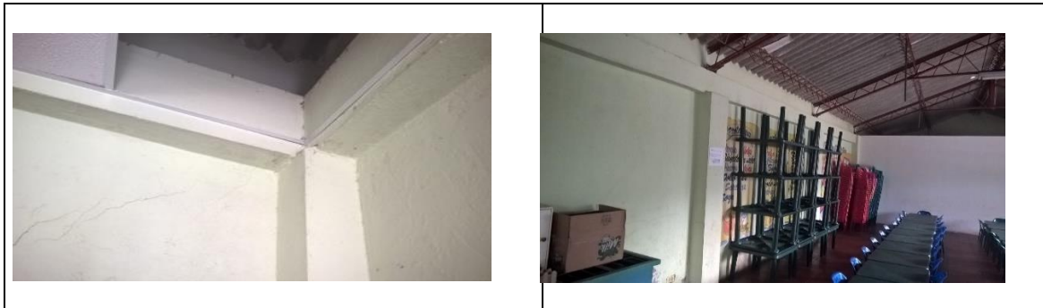
Foto 4. Columna adosada construida en el Restaurante de la edificación de la Institución Educativa Escuela Ciudad Jardín
