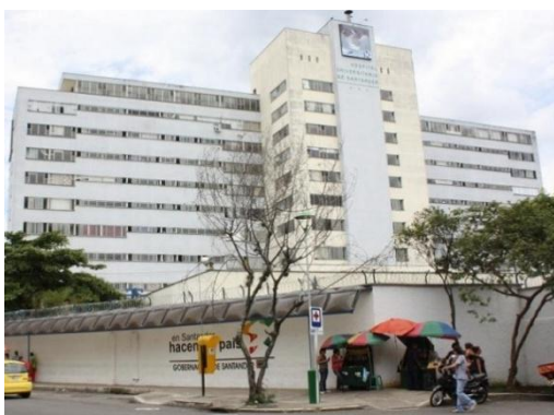
Figura 62. Vista panorámica HUS-Facultad de Salud UIS. Fuente Google Earth.
