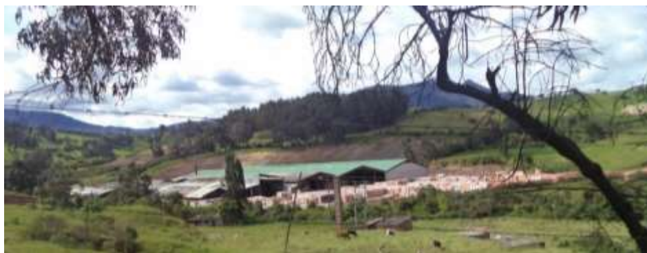
Fábricas de ladrillo
