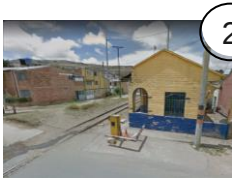
Conexión vía férrea
