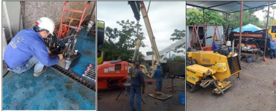
Figura 1. Inspección de condiciones locativas (materiales e infraestructura) y conductas de los trabajadores.
